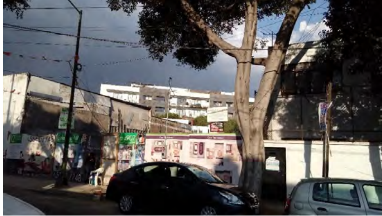
Calle Balboa, condominio en obra
