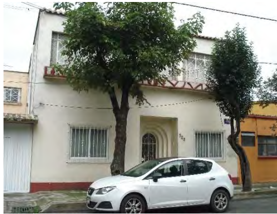
Calle Pirineos, edificios de 1980 y casas de 1950
