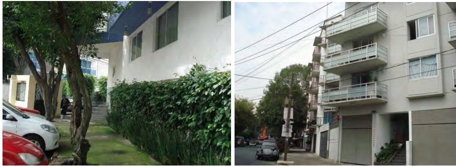
Escaleras para acceso peatonal
