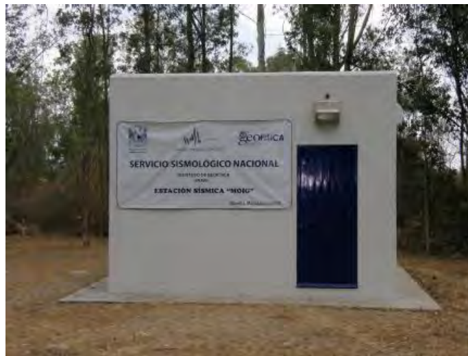
Figura 3.2 Exterior de la estación sismológica de Morelia Michoacán [MOIG] (Servicio Sismológico Nacional, 2017).
