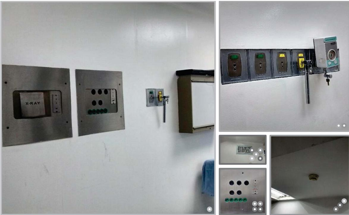
○ CONEXIONES: RAYOS X, GASES Y ELECTRICAS ESPECIALES. PANTALLA PARA RADIOGRAFÍAS ○ CONEXIONES PARA GASES MEDICINALES ○ DETECTOR DE HUMO ○ PLACA DE INSTALACIÓN ELECTRICA ○ REJILLA DE AIRE LAVADO
