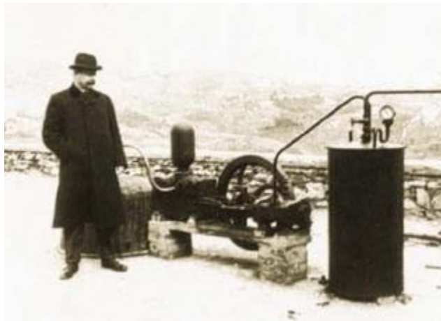
Figura 1-2.-Piero Ginori Conti, 1904. Primer generador de energía eléctrica a partir de geotermia.
