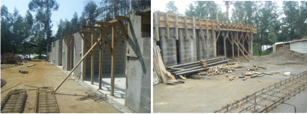
Imágenes 66 y 67. Firme colado e inicio de levantamiento de muros.
