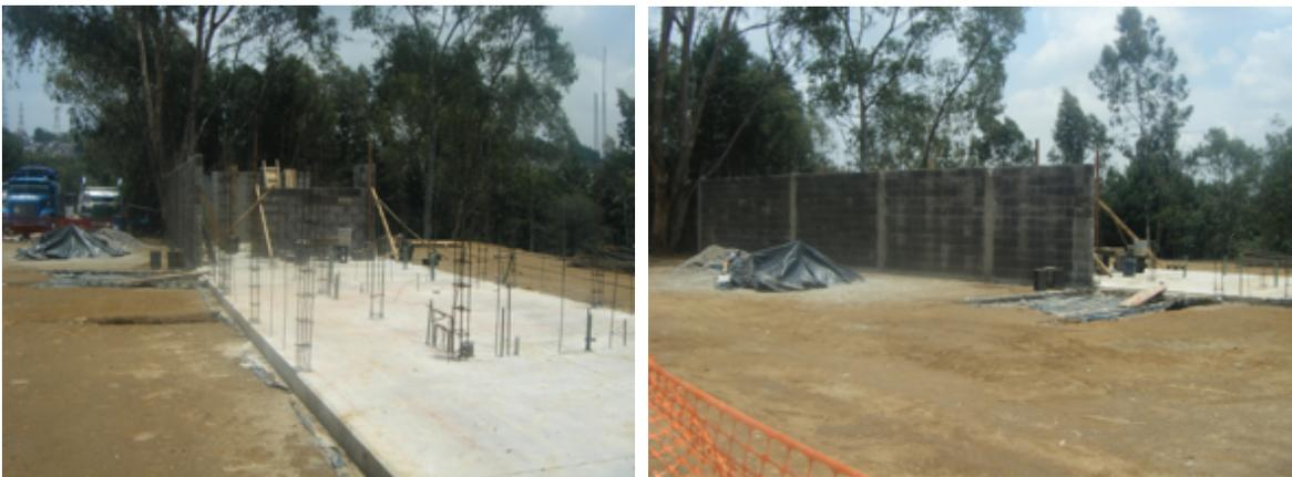
Imágenes 64 y 65. Firme colado e inicio de levantamiento de muros
