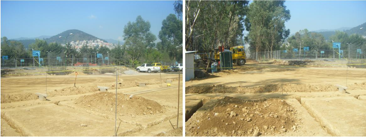
Imágenes 61 y 62. Compactación del producto de excavación del sistema vial para conformación de cimentación
