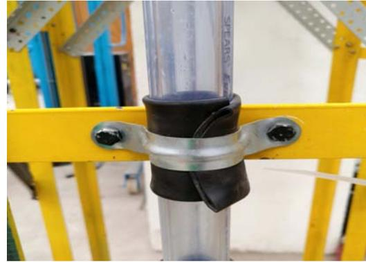
(b) Sujeción de tubería
