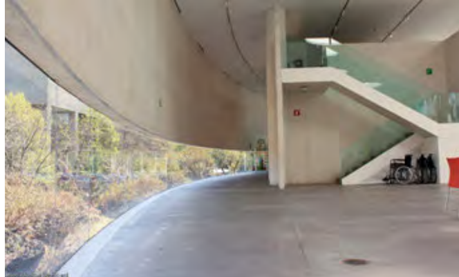
Imagen 103: Acabado aparente de concreto blanco liso en piso.
