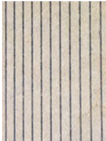
Imagen 104: Acabado aparente de concreto gris con estriado al vertical.
