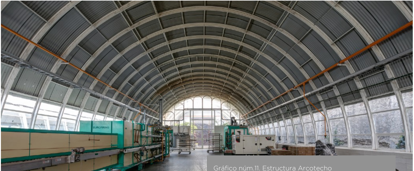
Gráfico núm.11. Estructura Arcotecho Proyecto "CERÁMICA SURO"
