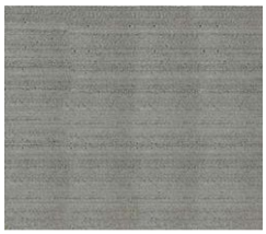
1. Concreto armado, acabado escobillado
