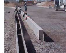
7. Guarnición de concreto armado
