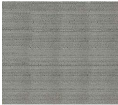
2. Concreto armado acabado escobillado
