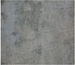
1. Concreto armado, acabado aparente
