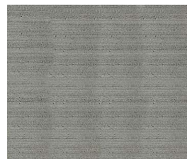
Firme de concreto
