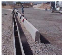
3. Guarnición de concreto armado
