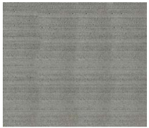
1. Concreto armado acabado escobillado
