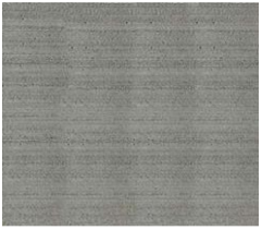
1. Concreto armado, acabado escobillado
