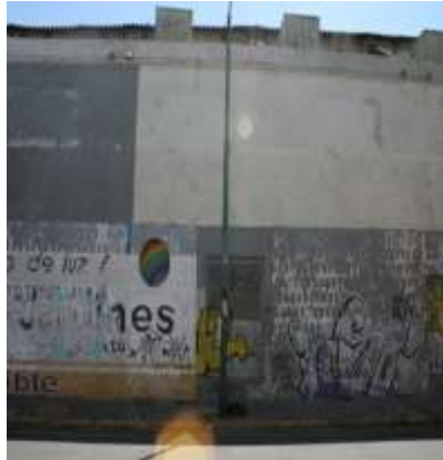
F-18 VISTA OESTE A PREDIO
