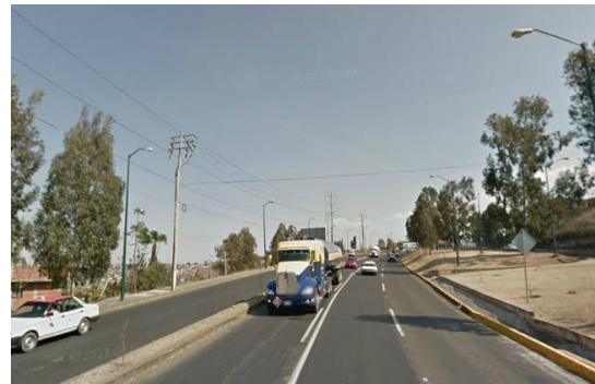
Vehículos pesados en carriles centrales.
