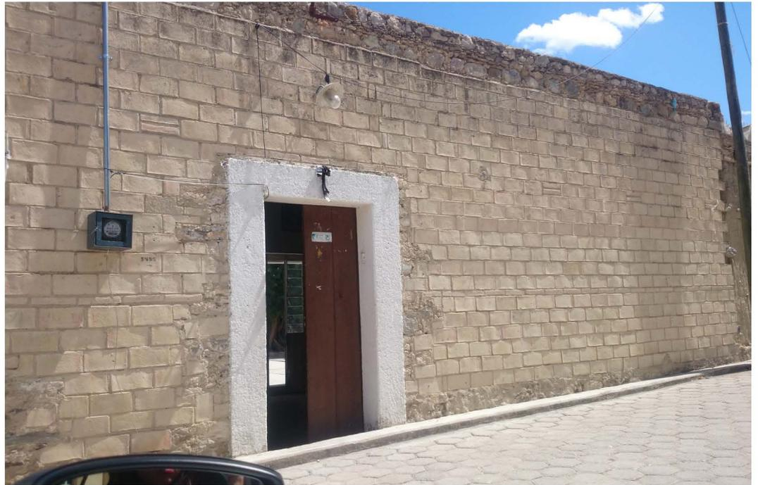
Los sistemas constructivos utilizados en la vivienda de materiales industrializados son: piso de cemento, muros de tabique rojo, tabicón gris y cubiertas de losa de concreto.
