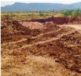
**Tepetate:** Capas de tierra sólida formadas por arcillas y arenas calcáreas que se cortan en bloques y se aprovechan en la construcción de muros, los bloques se cortan generalmente en dimensiones de 20x20x40cm para formar tabiques, tabicones o losetas.
