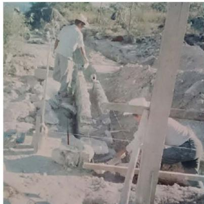
Se debe impermeabilizar la capa superior del cemento con una capa de emulsión asfáltica (agua, asfalto y emulsión). El adobe se coloca de manera cuatrapeada al hilo (por su dimensión más grande) o a tizón (por su dimensión más pequeña) procurando que las juntas no sean mayores a 3cm.
