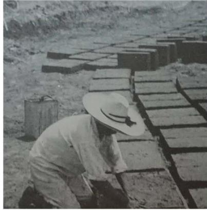
Se realiza un molde de madera o garrilla, para que la mezcla no se pegue en las paredes del molde se deberán de mojar todas las paredes, se rellena el molde y se presiona con las manos la mezcla, se retira el molde y se deja secar el bloque. Los adobes se dejan secar hasta que se endurecen, este proceso toma de 2 a 3 semanas.
