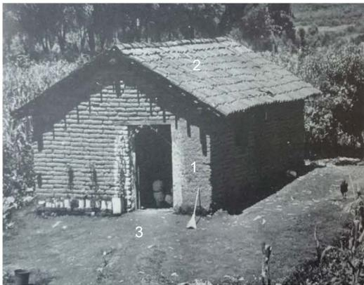
1. Cubierta de teja de barro    2. Muros de adobe    3. Suelo natural sin plataforma
