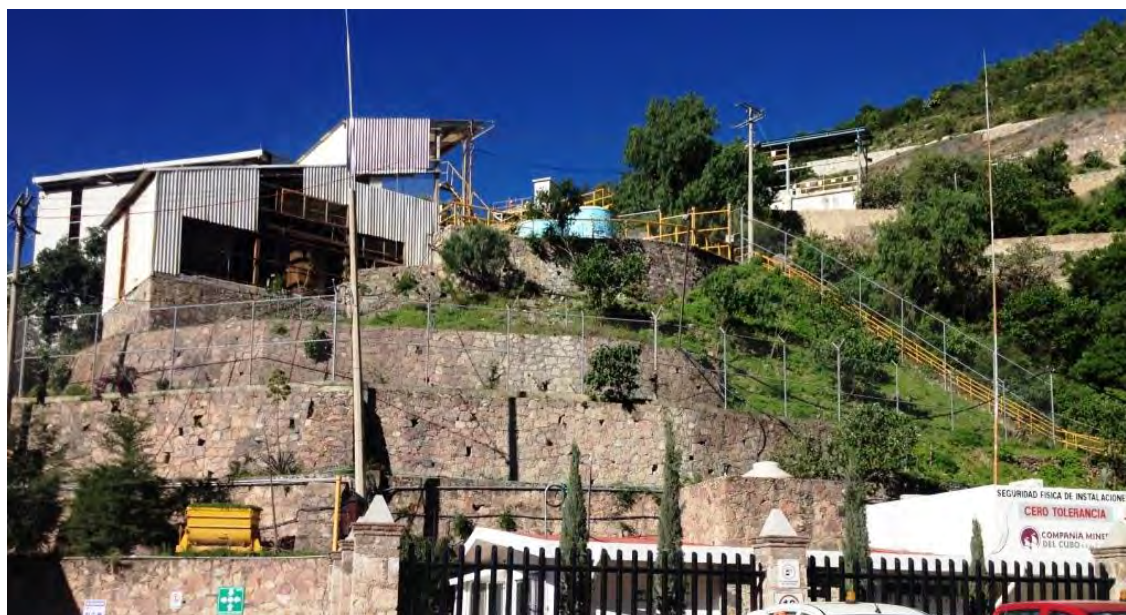
Figura 25. Planta de beneficio de la Unidad Minera El Cubo, 2017
