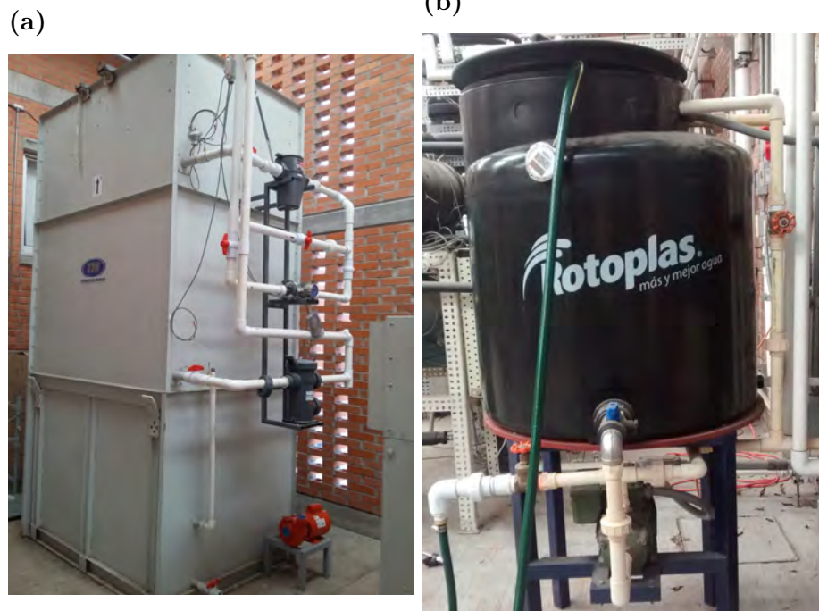
Figura 3.14: (a) Sistema de agua helada; (b) Sistema de torre de enfriamiento húmedo
