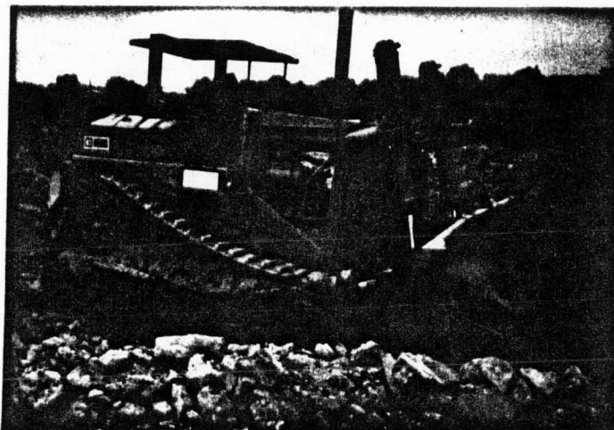
Fig. VI-1 Tractor de otuga D9L carterpillar uno de los más grandes en el mercado realizando corte de material en banco de préstamo.
