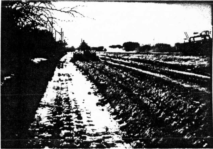
Fig. VII-24 COMPACTADOR DE IMPACTO REALIZANDO TRABAJO DE EXTENDIDO DE MATERIAL Y A LA VEZ COMPACTANDOLO.
