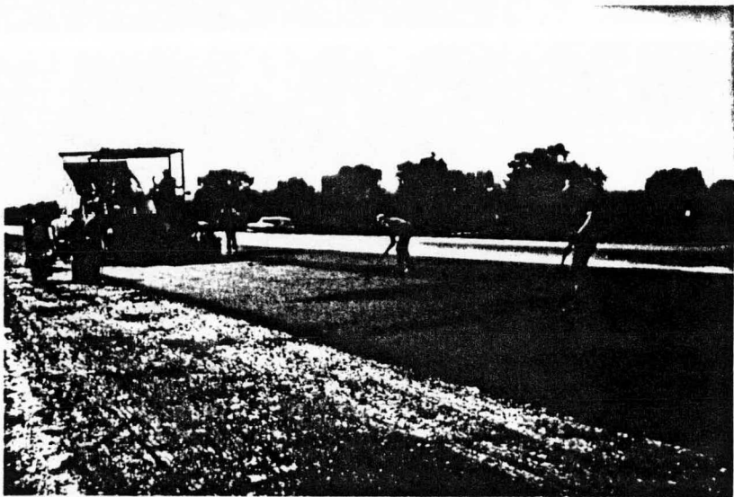
Fig. VI-20 Extendedora realizando trabajos de extendido de mezcla asfáltica en frío.
