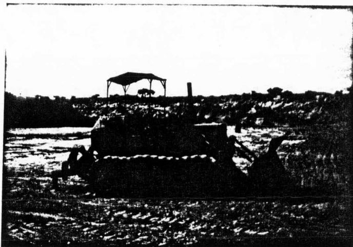
Fig. IV-17 Cargador frontal montado sobre orugas (traxcavo)
