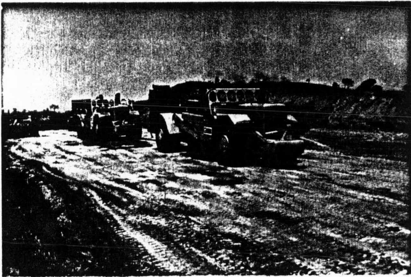
Fig. V-14 Motoescrepa lista para realizar la descarga del material.
