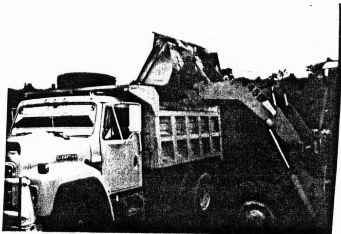
Fig. V-2 Camión volteo cargado de material para terracerías.
