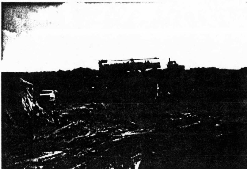
Fig. V-4 Pipa descargando asfálto rebajado en depositos de almacenamiento previamente calentado.
