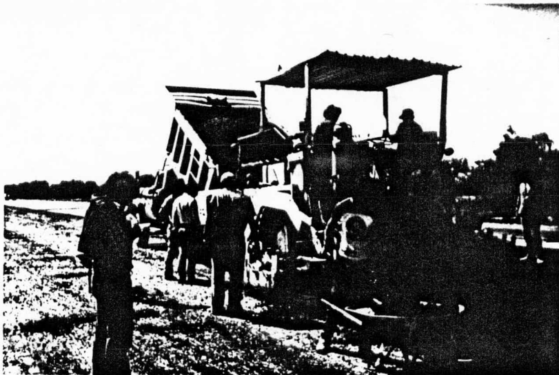
Fig. VI-17 Extendedora empujando camión cargado con mezcla asfáltica.
