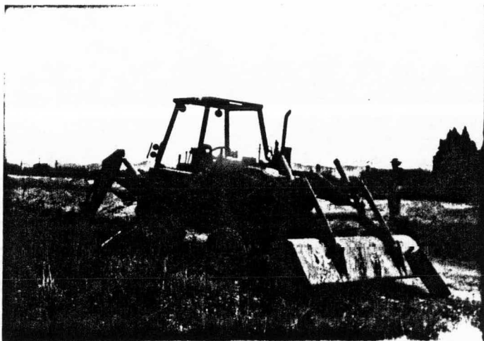
Fig. IV-3 Retroexcavadora realizando excavación en canal.
