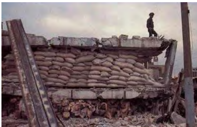
Figura 1.29. Colapso por masa excesiva en entrepiso debido a un cambio en el uso que se le destina al edificio (Munchener Ruckversicherungs, 1986).
