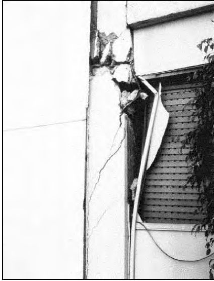
Figura 1.5. Falla por fuerza cortante en columna de planta baja (Northridge, 1994)
