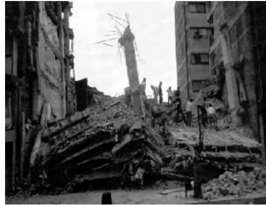
Figura 1.10. Falla por punzonamiento de la losa (Munchener Ruckversicherungs, 1986)
