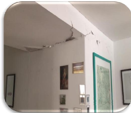
Imagen 23 unión de elementos estructurales dañado
