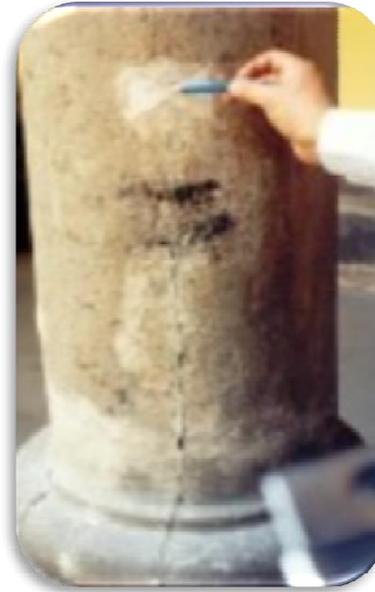
Imagen 49 Testigo de Yeso en Columna agrietada
