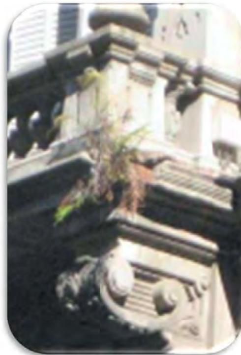
Imagen 43 Elemento de concreto con presencia de Plantas y Animales
