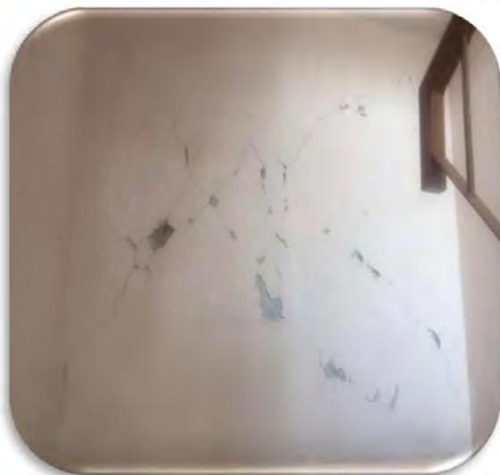
imagen 30 Grietas debido a carga dinámica
