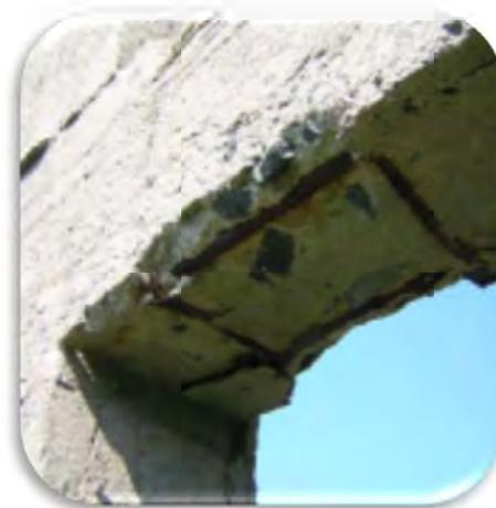
Imagen 40 corrosión armado de una viga
