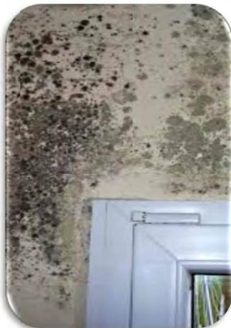
Imagen 18 Moho en Oquedades de Pared de Concreto
