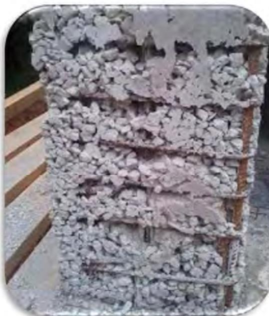
Imagen 8 Poco recubrimiento y pobre instalación de concreto
