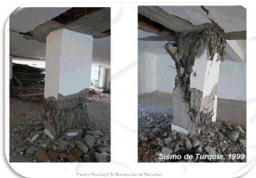
**Imagen 7 fallas por compresión y flexo compresión**
