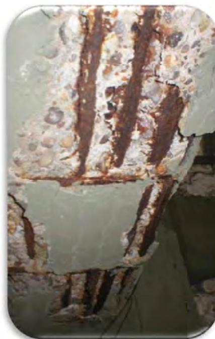
Imagen 19 Corrosión de armaduras
