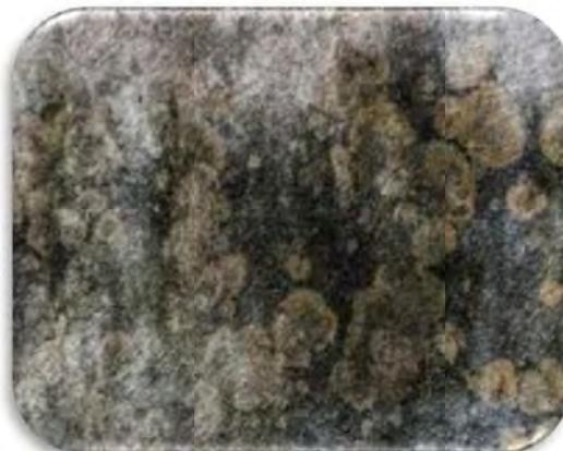
Imagen 17 Concreto con aparición de Moho
