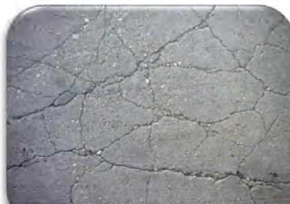
imagen 2 Agrietamiento por contracción plástica
