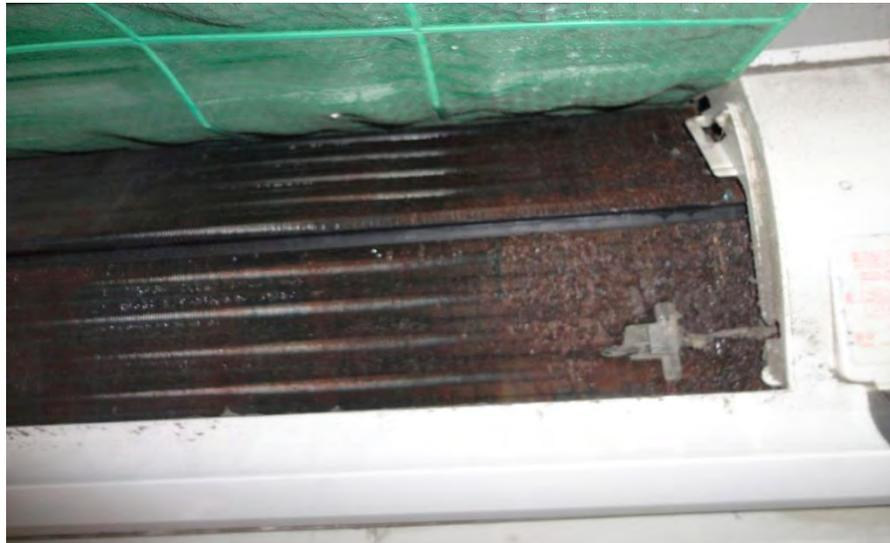
Foto 3.28. Serpentín de Unidad Evaporadora en mal estado M.S-02
