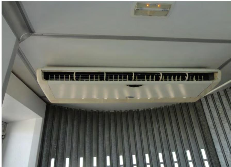
Foto 3.29. Unidad Evaporadora en mal estado M.S-03
