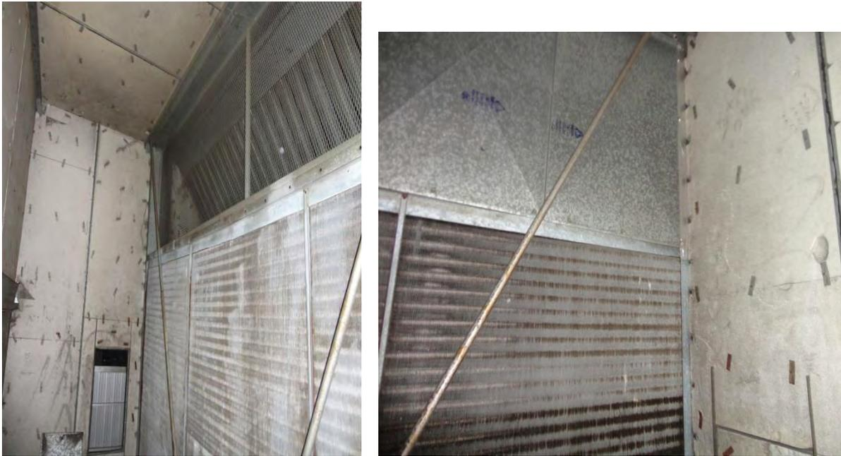
Foto 3.6. Parte interna de UMA-05 y Serpentina sucia y lodo.
