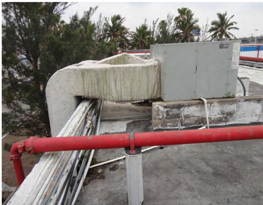
Foto 3.26. Aislamiento térmico de ductos y tuberías dañado U.P-02
