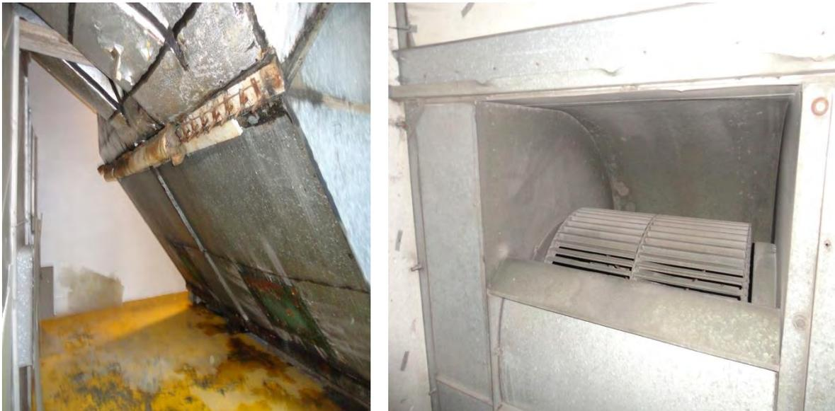
Foto 3.7. Fugas en las uniones de ductos y Revisión de turbina.
