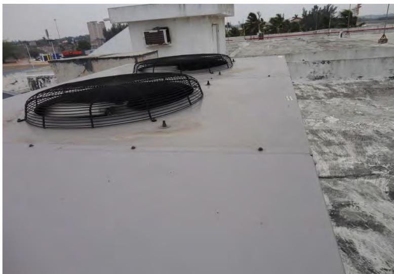
Foto 3.15. Aspas del ventilador en buen estado y limpias.
