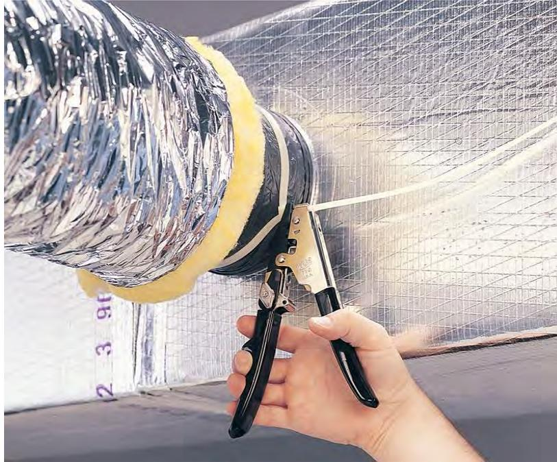
Foto 2.5 Instalación de ducto flexible
