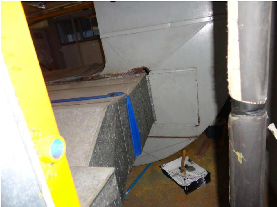
Foto 3.20. Presencia de orificios en ductos principales de inyección Unidad Manejadora de Aire UMA-09.
