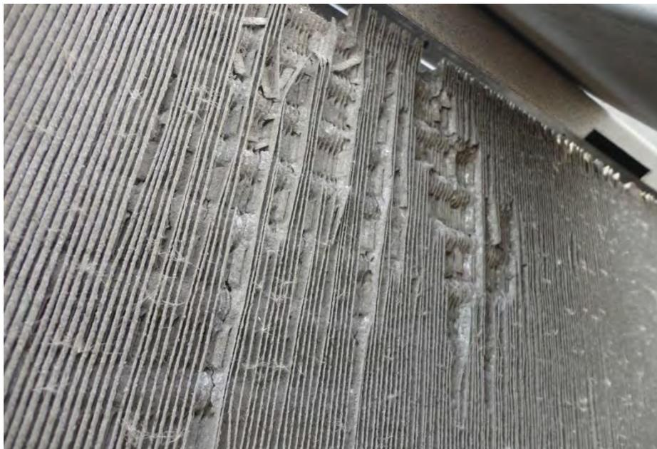
Foto 3.18. Presencia de lodo, aletas rotas y obstruidas U.C-08.
