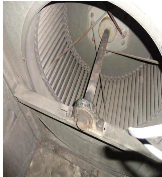
Foto 3.5. Bandas en buen estado y Flecha de turbina con sarro y desbalanceado.
