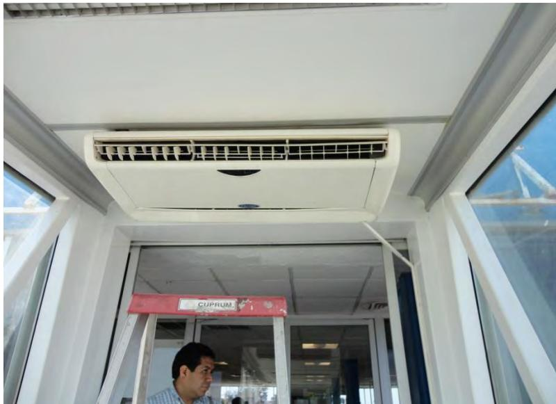
Foto 3.30. Unidad Evaporadora en mal estado M.S-04
