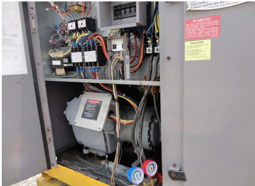
Foto 3.12. Revisión de motor eléctrico y contactores de U.C-03.
