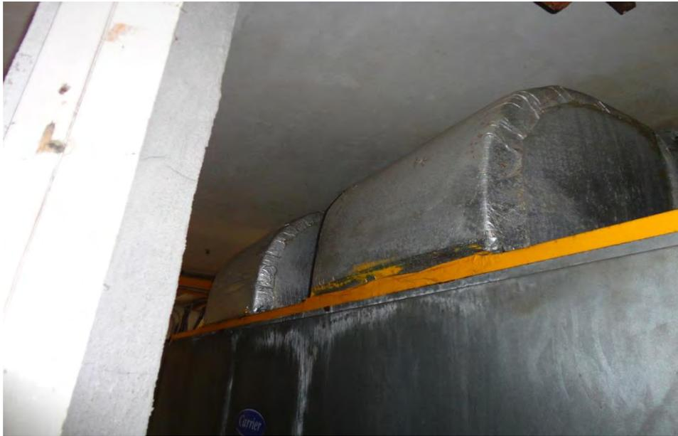
Foto 3.21. Aislamiento de ductos dañados UMA-09.
