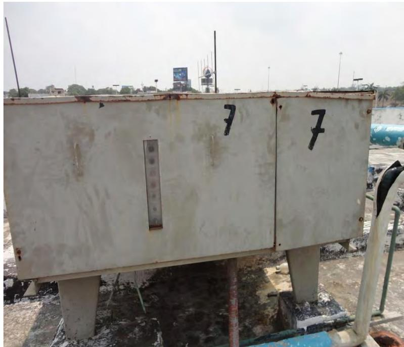
Foto 3.16. Gabinete dañado y pintura en malas condiciones U.C-07.
