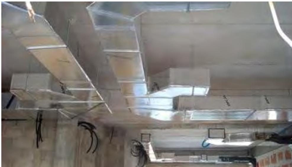
Foto 2.1 Instalación de ductos de Aire Acondicionado
