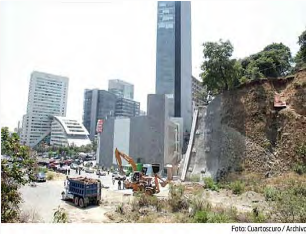
Figura 1. Obras en proceso en Av. Vasco de Quiroga
