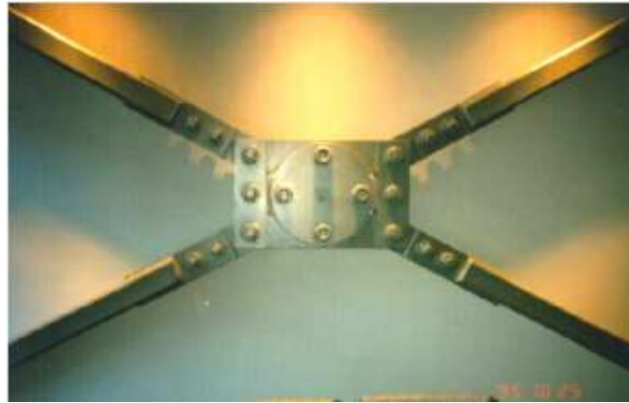
Figura 1.6. Amortiguador Pall. Fuente: http://www.palldynamics.com
