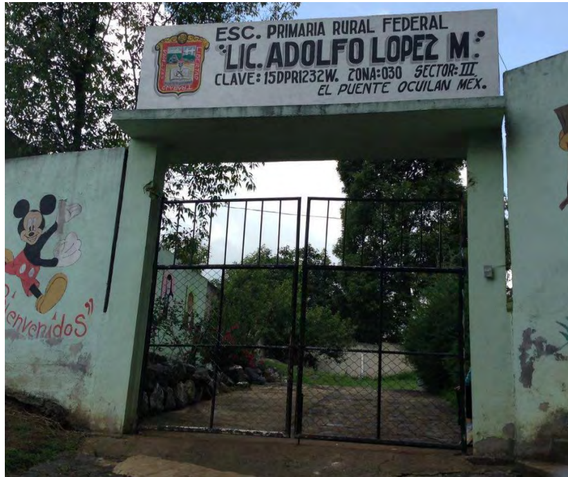
Entrada principal de la Escuela Primaria Lic. Adolfo López Mateos, en la comunidad El Puente, Ocuilan, Estado de México.
