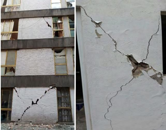
*Figura 1.25 Muros con falla por cortante por falta de confinamiento (fotografías por Andrés Priego y Ángel Moreno, 2017)*
