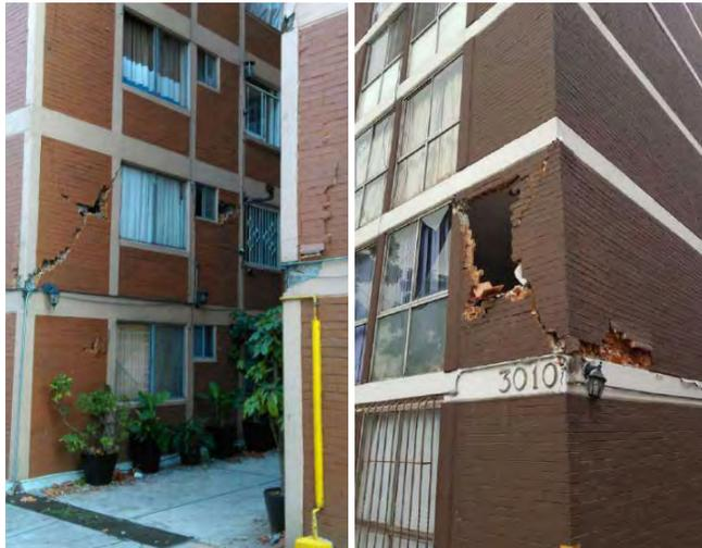
*Figura 1.26 Falla en confinamiento de muros en edificios habitacionales (fotografías por Alberto Baldovinos, 2017)*
