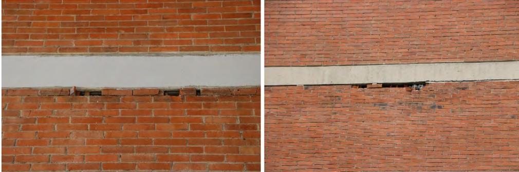
Figura 2.14 Muros diafragma dañados en la zona de contacto con las losas planas en los edificios tipo D y E (archivo personal, 2018)
