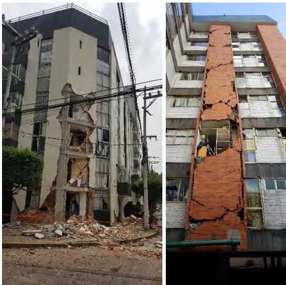
Figura 1.24 Edificios con daños en la cubierta de mampostería en la Colonia del Valle (fotografías por Ángel Tolen, 2017)
