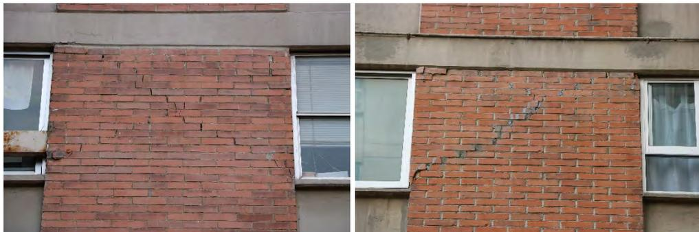
*Figura 2.13 Muros de los edificios tipo D y E con daños por cortante, el de la derecha exhibe una reparación incorrecta (archivo personal, 2018)*
