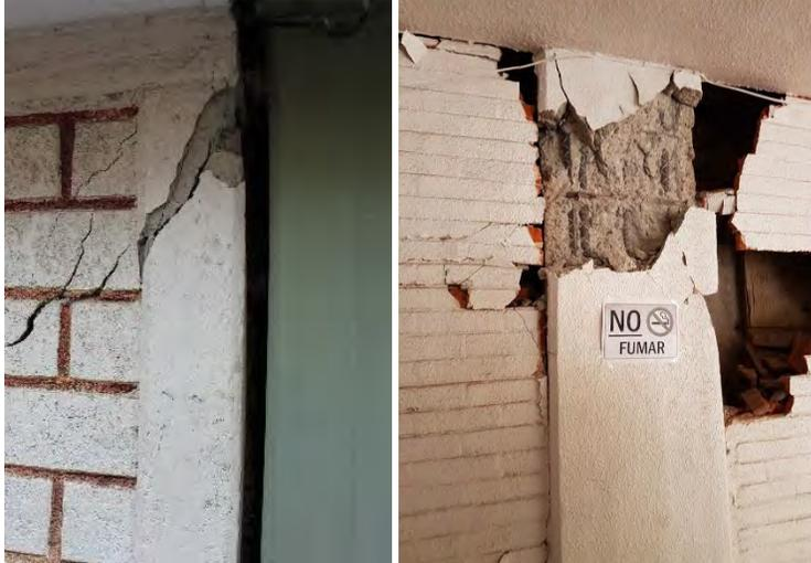
Figura 1.27 Columnas con daños por cortante y en recubrimiento en edificios habitacionales de la Ciudad de México (fotografías por Pablo Pardavé y Andrés Priego, 2017)
