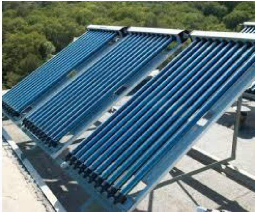
Imagen 202. Calentadores solares
