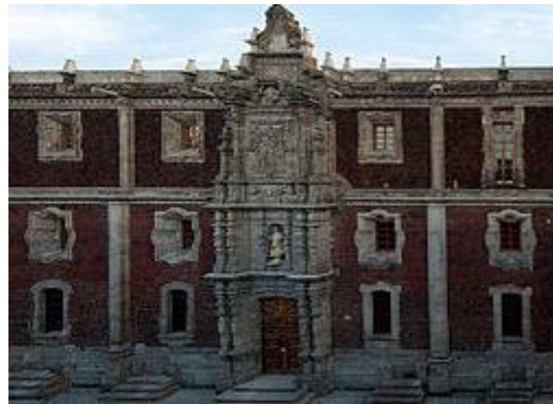
Imagen 15. Fachada del patio chico del Antiguo colegio de San Ildefonso, Centro histórico de la Ciudad de México. Surge de la unión del colegio de San Bernardo, San Miguel y San Gregorio en 1583.
