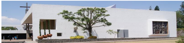
Imagen 29. Vista de la capilla desde el acceso principal.
