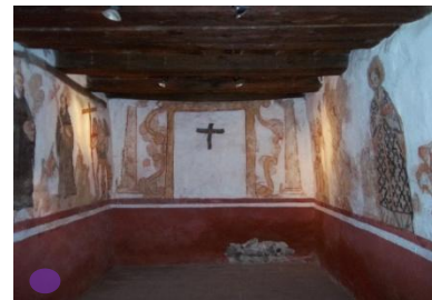
Imagen 102. Materiales y estructura: Vigas de madera, pisos de piedra y pinturas murales.
