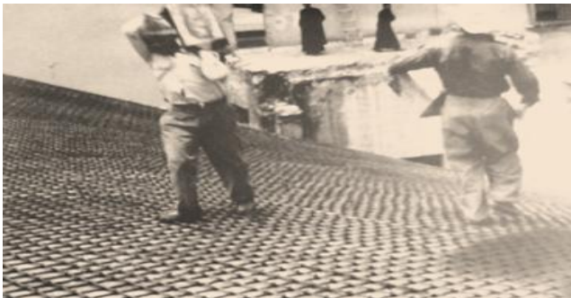
Imagen 45. Habilitado de acero.
