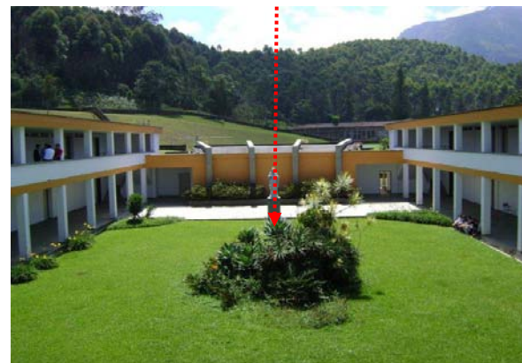
Imagen 74. Aulas a los costados y biblioteca al fondo.
