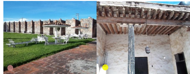
Imagen 106-107. De izquierda a derecha; Dormitorios, orientación Nor – este. Materiales de construcción: vigas y columnas de madera, muros de piedra.
