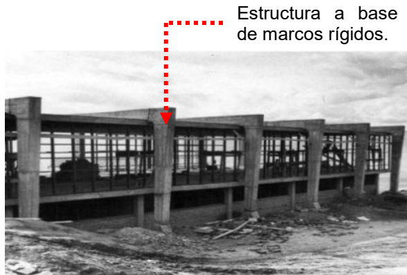
Imagen 71. Fotografía del proceso de construcción del edificio.
