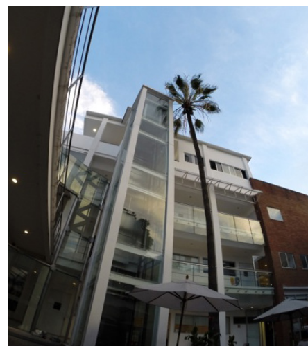
Instalaciones al interior Centro de Capacitación Cinematográfica
