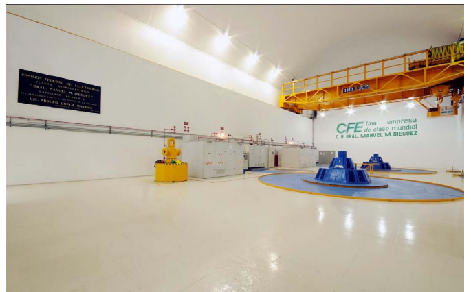
TRABAJOS CONCLUIDOS EN PISO PRINCIPAL
