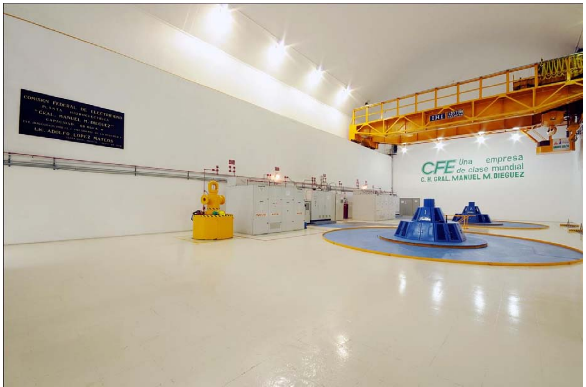
ASPECTOS DE TRABAJOS TERMINADOS EN EL INTERIOR DE CASA DE MAQUINAS
