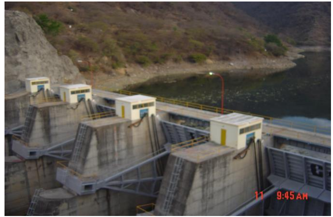
VISTA DE LAS COMPUERTAS DE VERTEDORES
