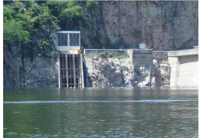
CASETA OBRA DE TOMA - EMBALSE
