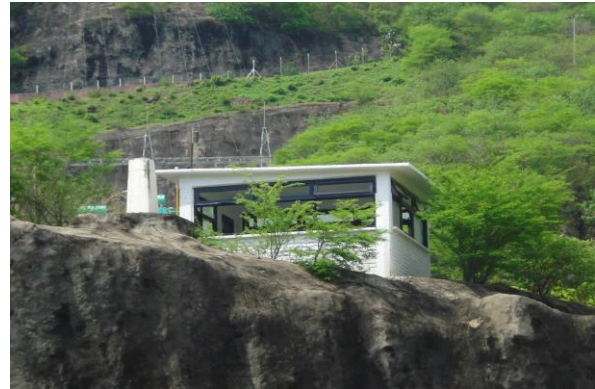
CASETA DE INSPECCIÓN
