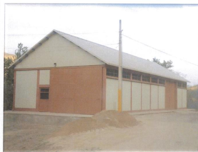
TRABAJOS CONCLUIDOS EN ALMACEN GENERAL
