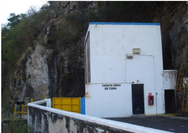
CASETA OBRA DE TOMA
