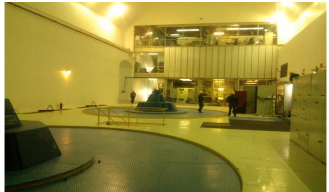
INTERIOR PISO PRINCIPAL CASA DE MÁQUINAS
