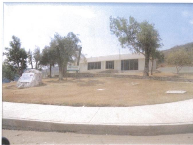
TRABAJOS CONCLUIDOS EN OFICINAS TECNICAS
