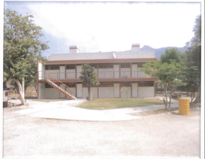
TRABAJOS CONCLUIDOS EN AREA DE COLECTIVOS
