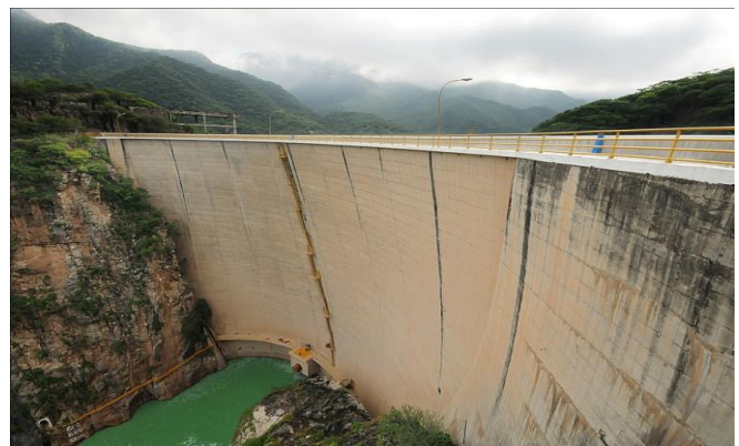
ASPECTO DE LA CORTINA DE LA CENTRAL
