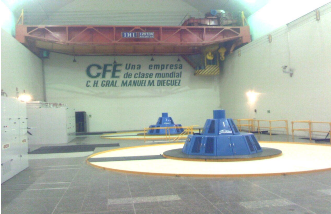
ASPECTOS DEL INTERIOR DE CASA DE MAQUINAS PREVIO AL INICIO DE LOS TRABAJOS
