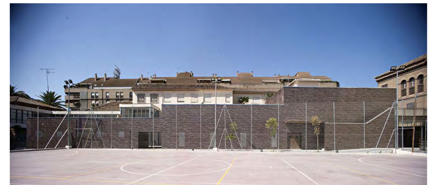
G.116 - Área Deportiva y Fachada
