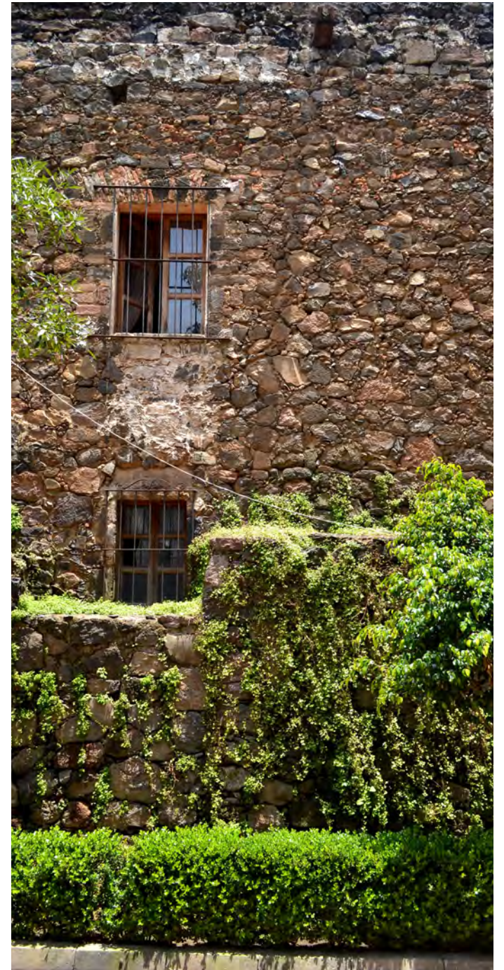
G.74 - Muro Lateral, desde Calle Francisco I. Madero
