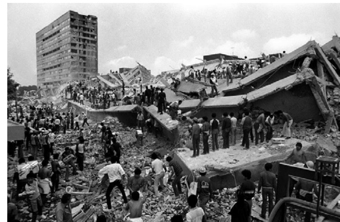
G.8 - Fotografía de Edificio Demolido en el Terremoto de la Ciudad de México- 1985
