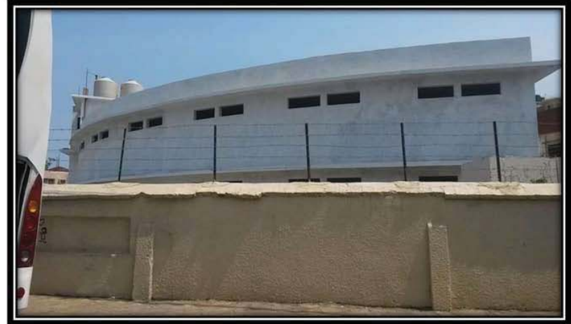
FIG.35. Imagen tomada en la “Casa Hogar del Niño de Acapulco” referente al EDIFICIO-4 . Fachada posterior de edificio en construcción.
