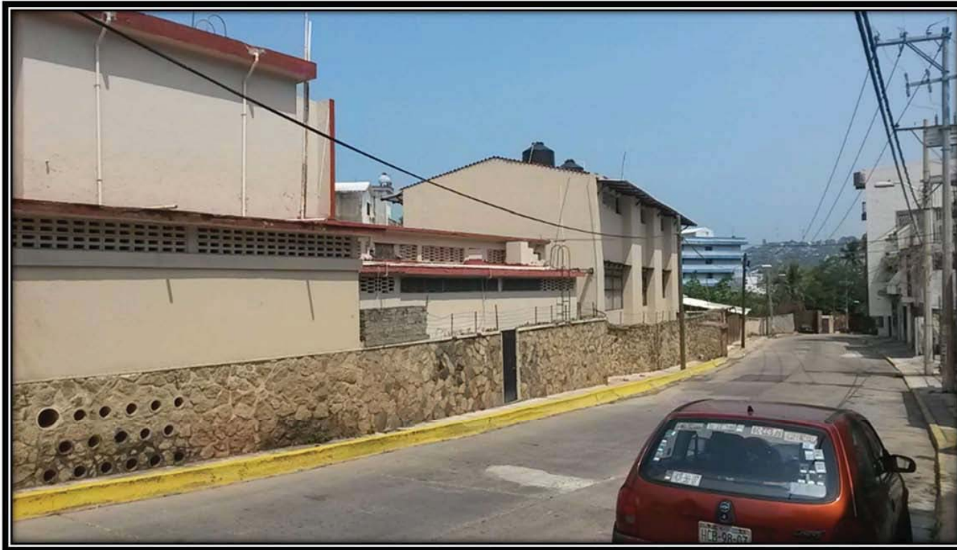
FIG.7. Ver figura 5. Para ver ubicación de la vista en planta, VE-2 vista exterior fachada este, AV. Gran Vía Tropical.
