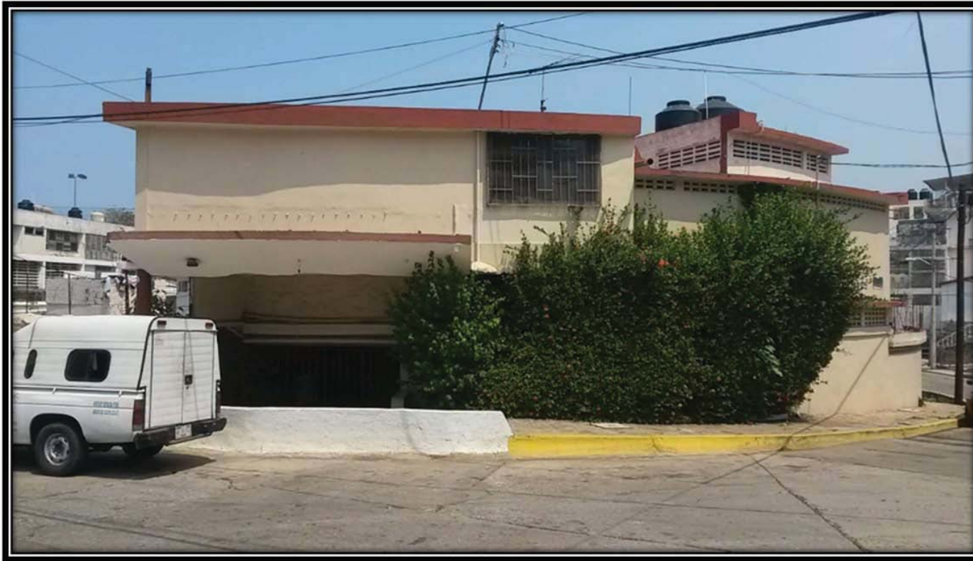
FIG.10. Ver figura 5. Para ver ubicación de la vista en planta, VE-5 vista exterior sur, fachada (acceso principal).
