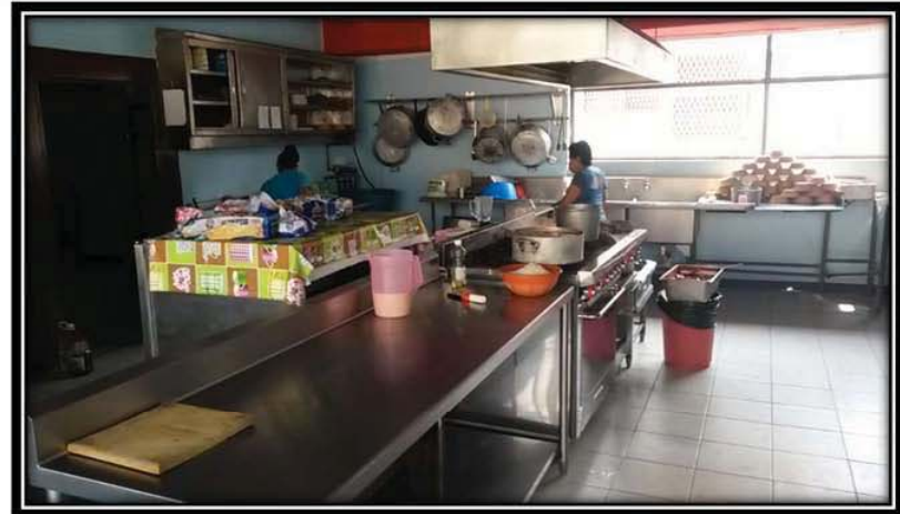
FIG.30. Imagen tomada en la “Casa Hogar del Niño de Acapulco” referente al EDIFICIO-3 Cocina.
