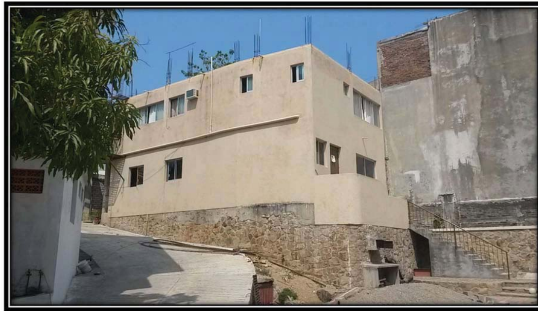
FIG.39. Imagen tomada en la “Casa Hogar del Niño de Acapulco” referente al EDIFICIO-5 . Fachada exterior del edificio.
