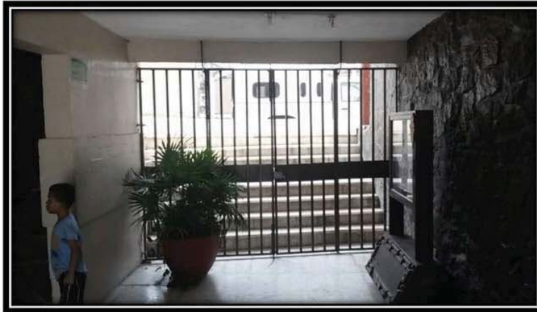
FIG.13. Imagen tomada en la “Casa Hogar del Niño de Acapulco” referente al EDIFICIO-1 . Acceso principal de la casa hogar.
