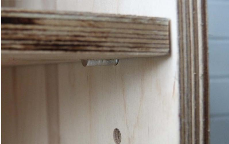
Elemento de sujeción para accesorios. Consiste en un perno que se introduce en las perforaciones de las caras internas laterales en el cual descansan los accesorios.
