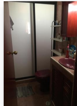
Baño Construcción tipo 2
