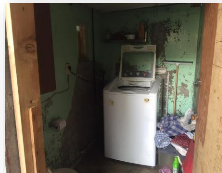
Baño construcción tipo 1
