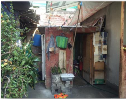
Baño Construcción tipo 1
