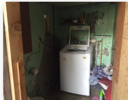
Baño construcción tipo 1
