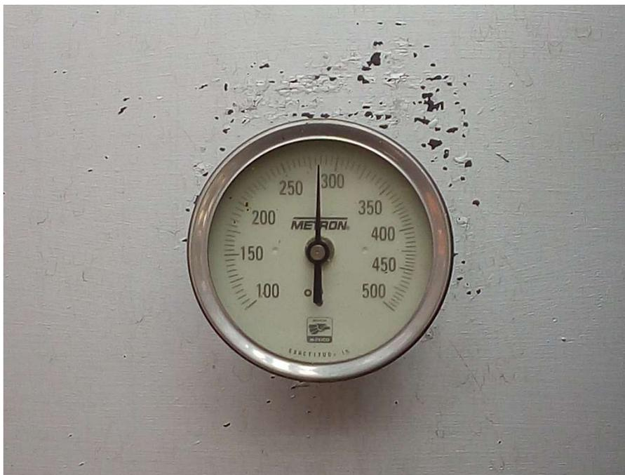
**Figura 17.** Termómetro de la cámara de incineración.
