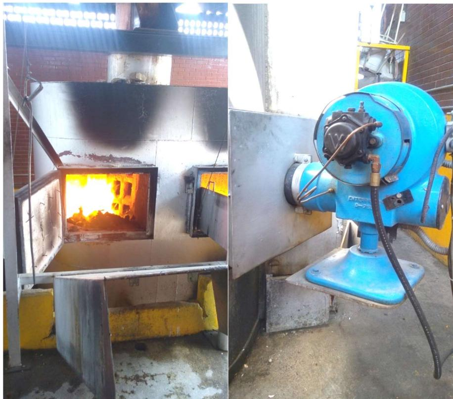
**Figura 13** (A). Cámara del incinerador abierta. (B). Bomba de diésel
