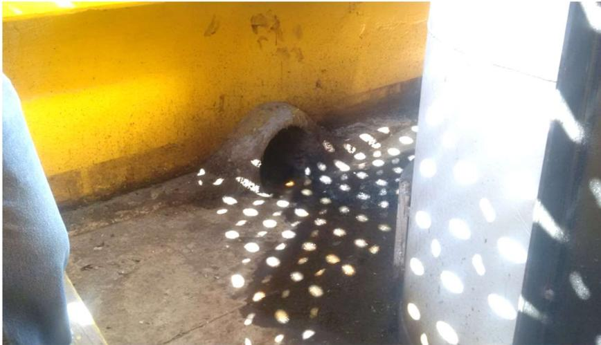
**Figura 21.** Salida hacia el pozo contenedor de líquidos.
