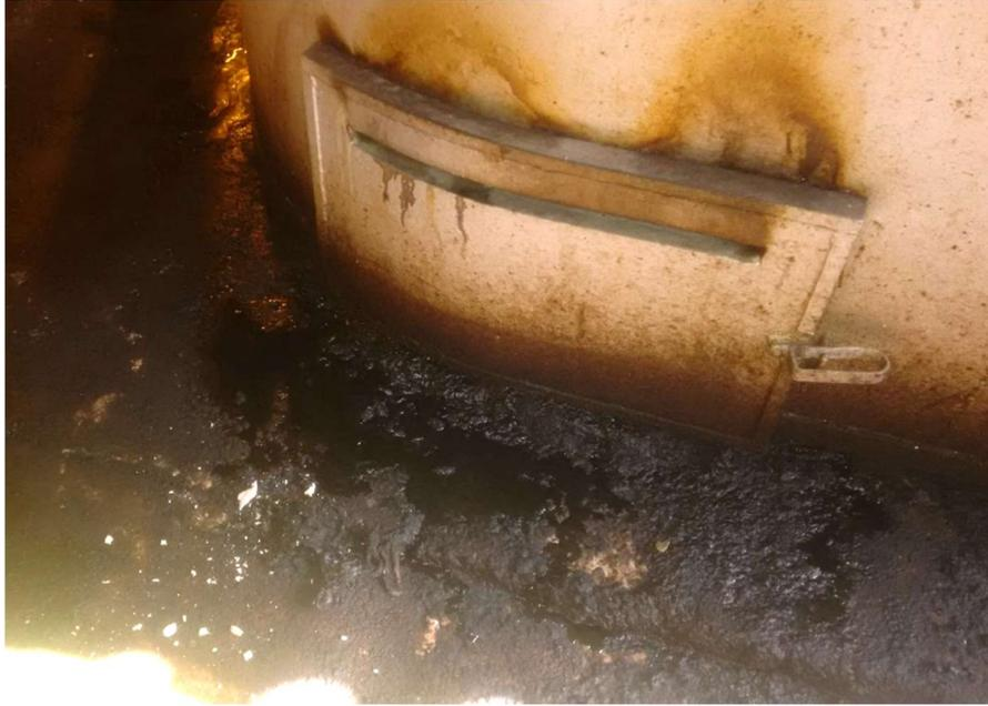
**Figura 16.** Compuerta por la que se retiran las cenizas resultado de la incineración.
