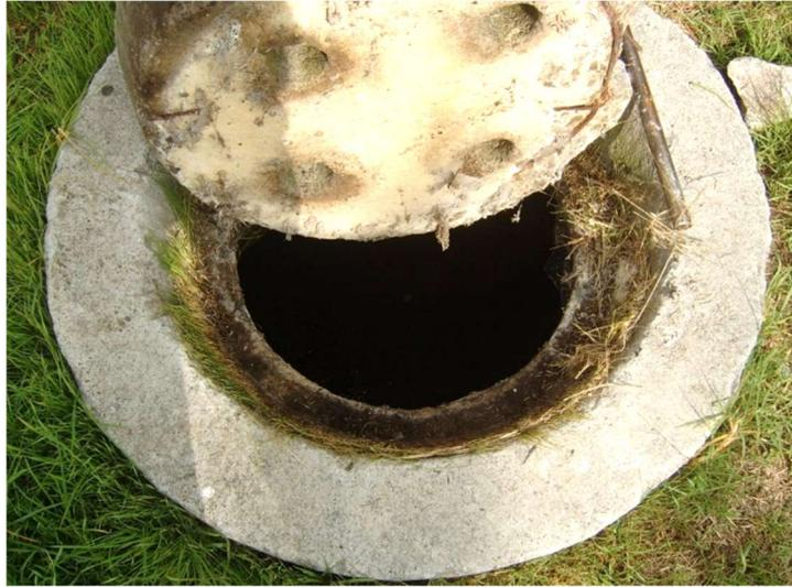
**Figura 22.** Tapa del pozo receptor
