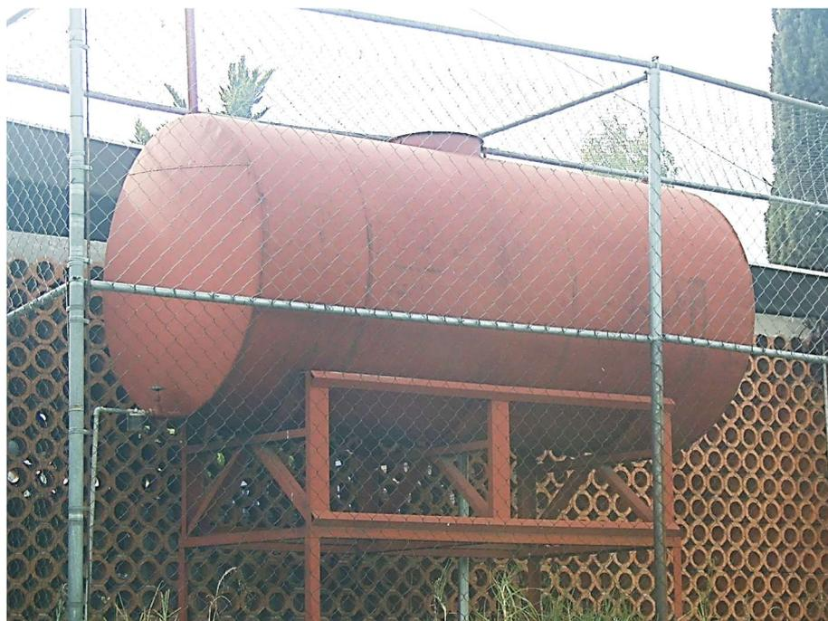
**Figura 11.** Tanque de Diesel que suministra al Horno Incinerador.
