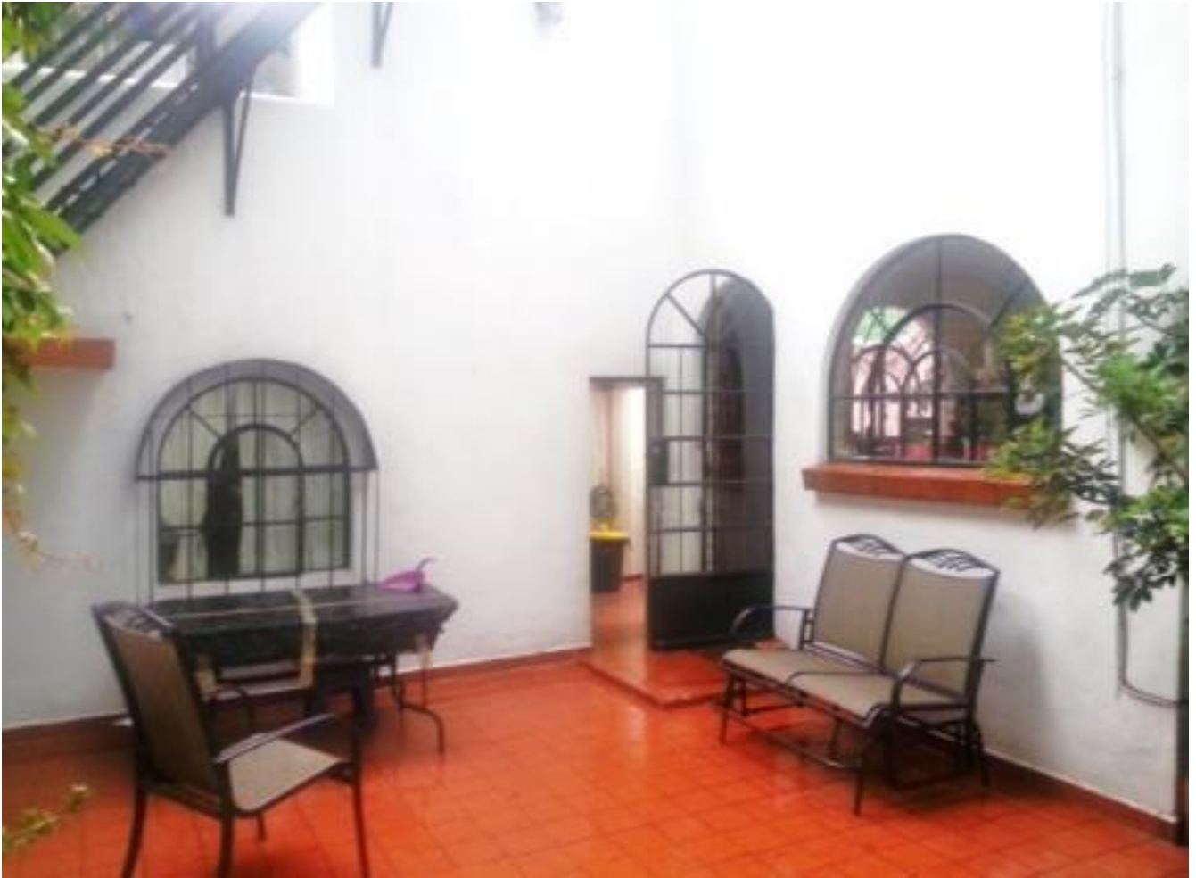
Fig. 3. Patio trasero (piso original).
