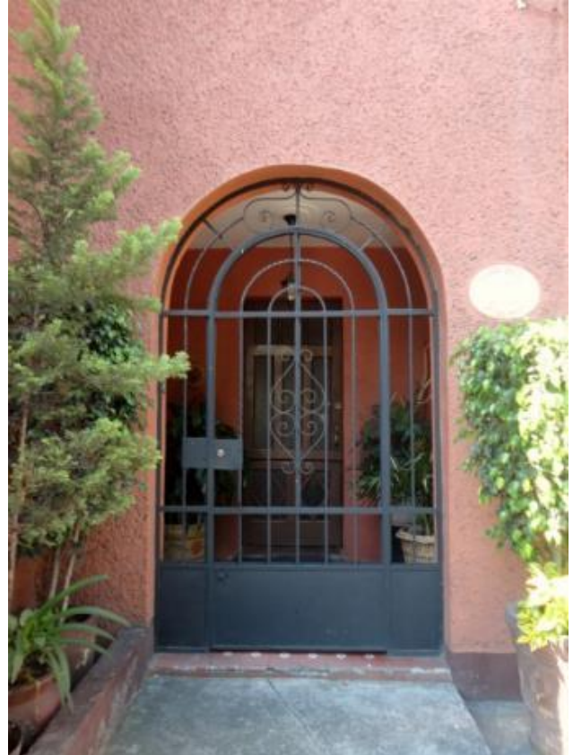
Fig. 46. Acceso principal (herrería original)
