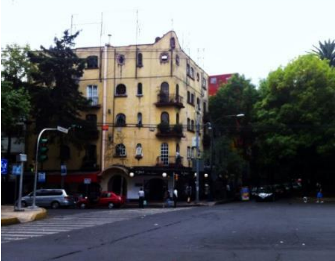
Fig. 58. Fachada de edificio de la década de 1940
