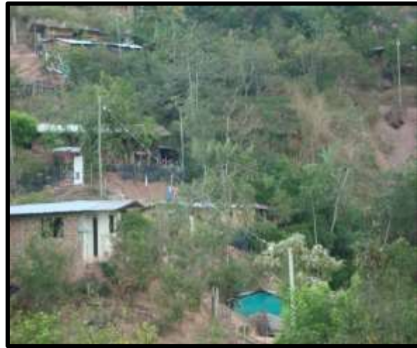
Foto 21. Amenaza por laderas inestables (Sector Nueva Colombia).
