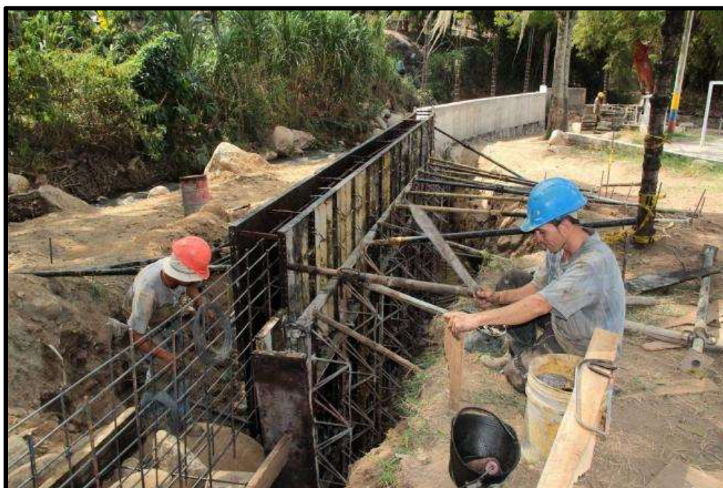
Foto 32. Desarrollo de la obra. Muro de contención del barrio Barroblanco. (Créditos: http://www.vanguardia.com ).
