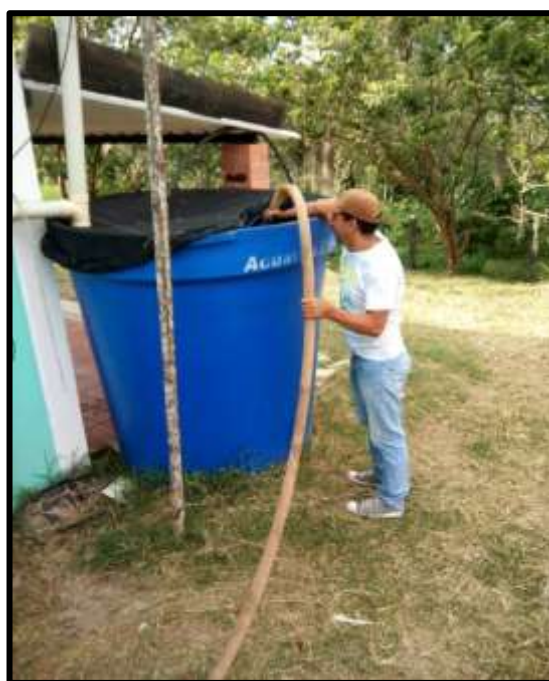
Foto 23. Tanques de almacenamiento.
