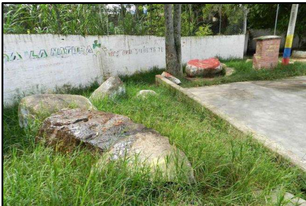
Foto 31. Muro de contención diseñado al inicio del proyecto de vivienda. (Créditos: http://www.vanguardia.com ).
