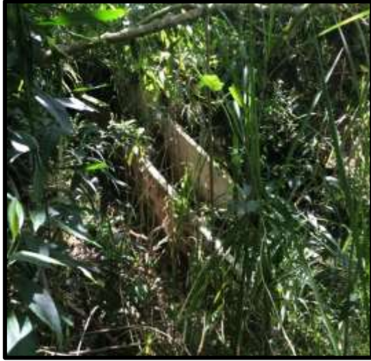
Foto 25. Canalización de aguas.
