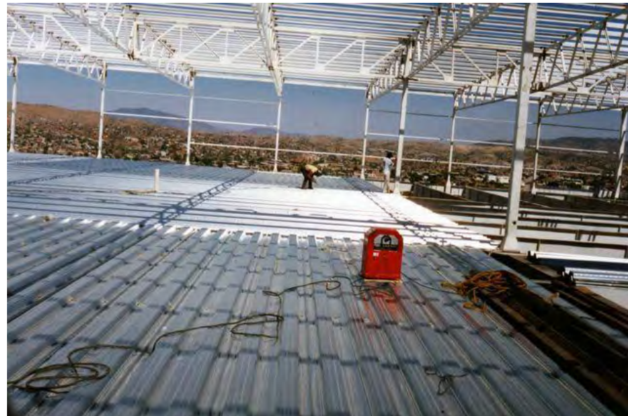
Ilustración 41: Losacero y Armaduras
