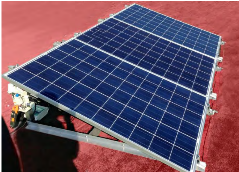
Figura 5.12. Medición de corriente con amperímetro de gancho.
