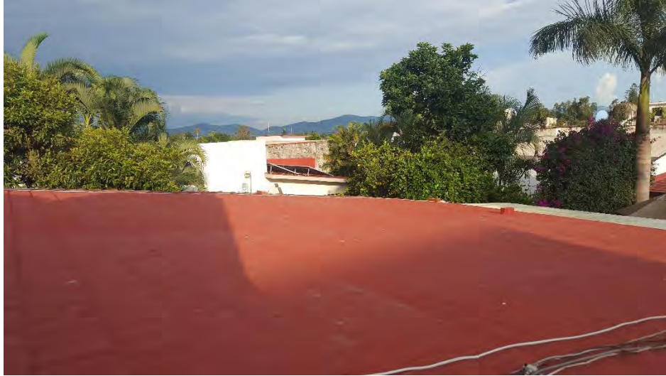
Figura 5.1. Techo de la casa.
