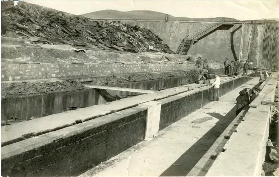
Figura 15. Cementación de cobre en canaletas (Ballester M. 2018)
