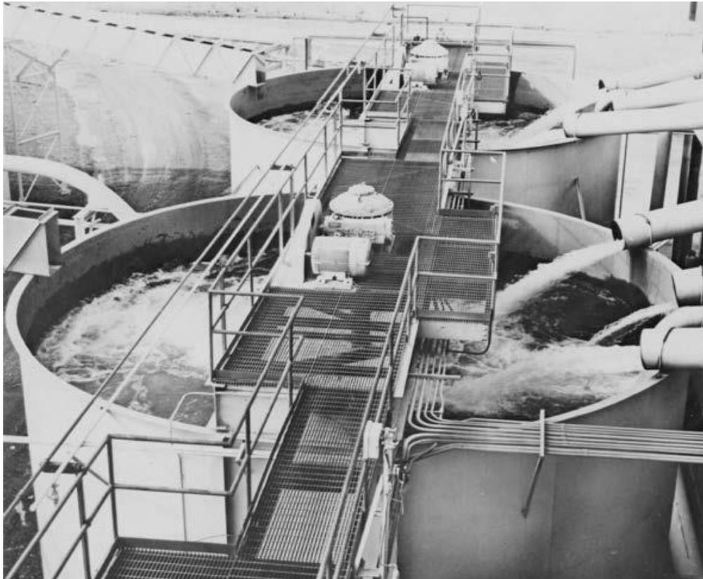
Figura 14. Tanques de lixiviación dinámica (Aguilar J., 2018)
