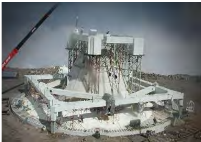
Primer piso terminado, en 2001 y estructura principal, en 2003 (Fotografías por David Hugues). 34
