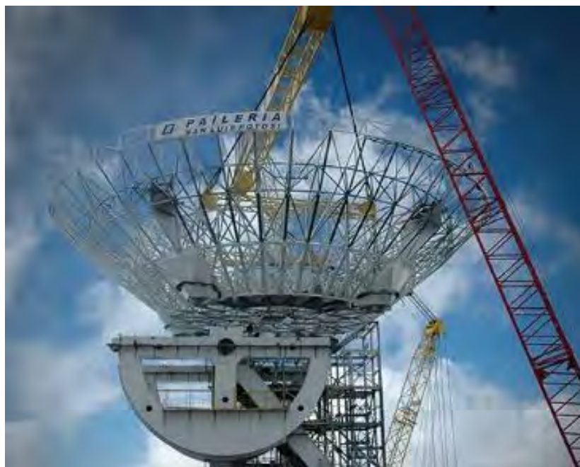
Colocación de la estructura en los soportes, 2005 (Fotografía por David Hugues). 37
