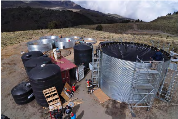
Construcción del prototipo VAMOS (Foto archivo HAWC). 75
