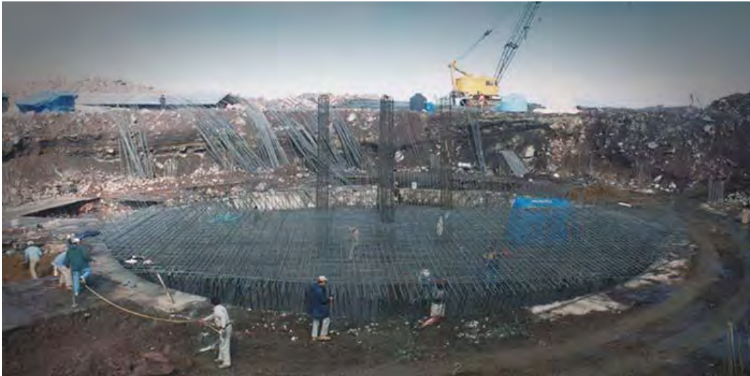
Construcción de cimientos, 1999 (Fotografía por David Hugues). 32
