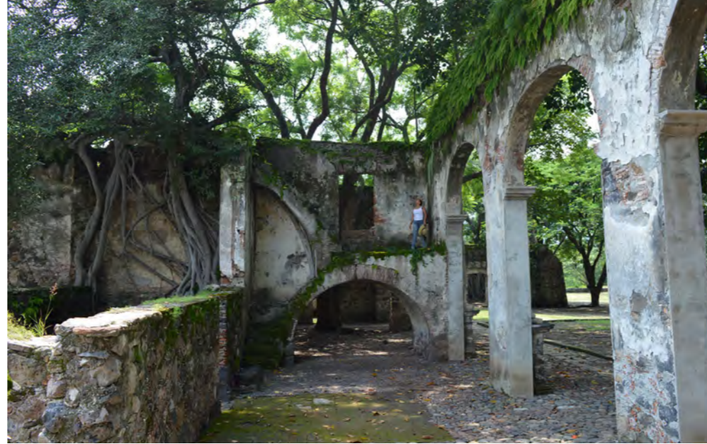
Gráfico 77. Escaleras de acceso a la segunda planta de la casa principal.
