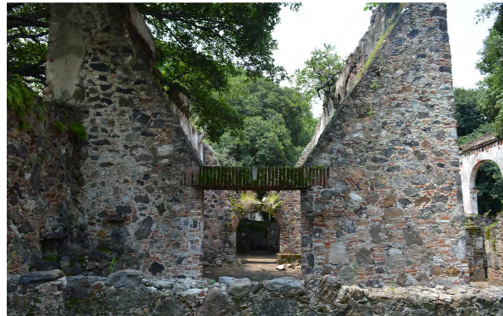
Gráfico 75. Vista de la parte trasera de las ruinas de la casa principal en la que destacan los muros con ángulos pronunciados y dintel de ladrillo.
