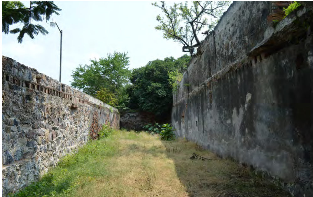
Gráfico 72. Vista interior de uno de los galerones en la que destaca la composición y recubrimiento de los muros, sin cubierta pero parte del sistema constructivo de este es visible.
