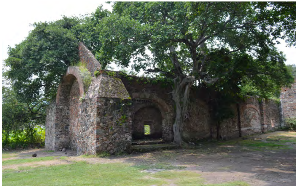
Gráfico 70. Vista exterior de las ruinas de lo que fue un vivero, sistema constructivo visible, muros sin recubrimiento.
