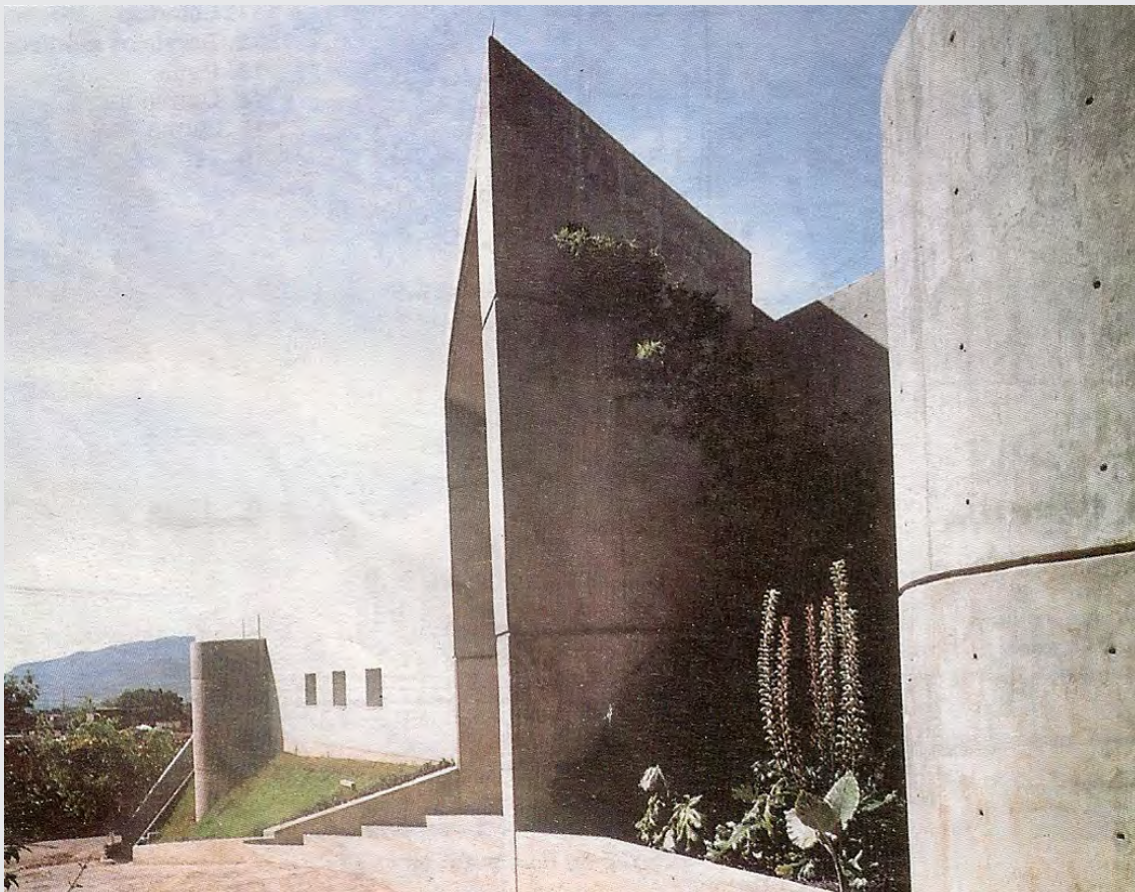
Gráfico 106: Acceso principal y vestíbulo exterior.
