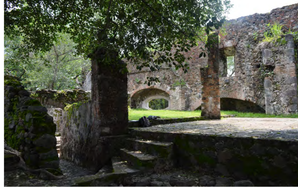
Gráfico 49: Zona de ruinas, las columnas se encuentran destruidas en la parte superior con presencia de vegetación agreste.
