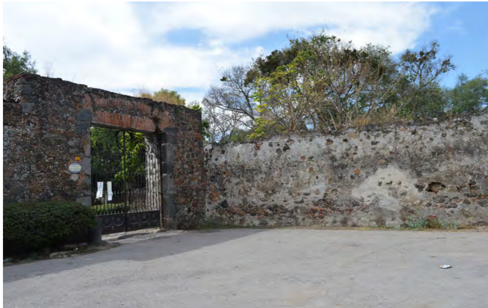
Gráfico 44: Acceso principal a la Ex-Hacienda de piedra y ladrillo, la forma de la cubierta es abovedada en capialzado.
