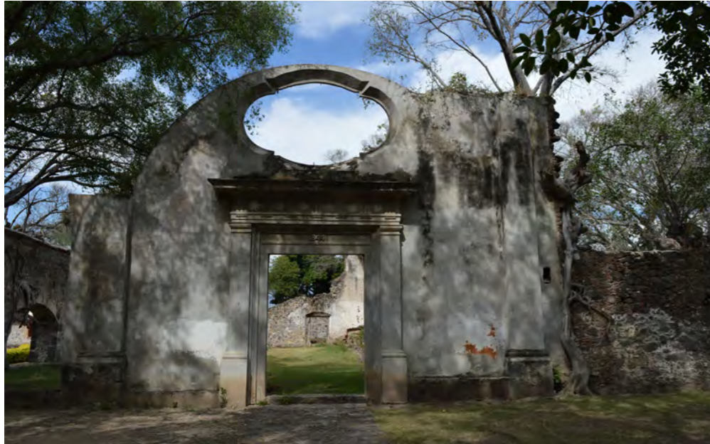
Gráfico 64. Fachada de acceso a ingenio de vapor del siglo XIX, con inscripción en alto relieve sobre el dintel, se lee "1844".
