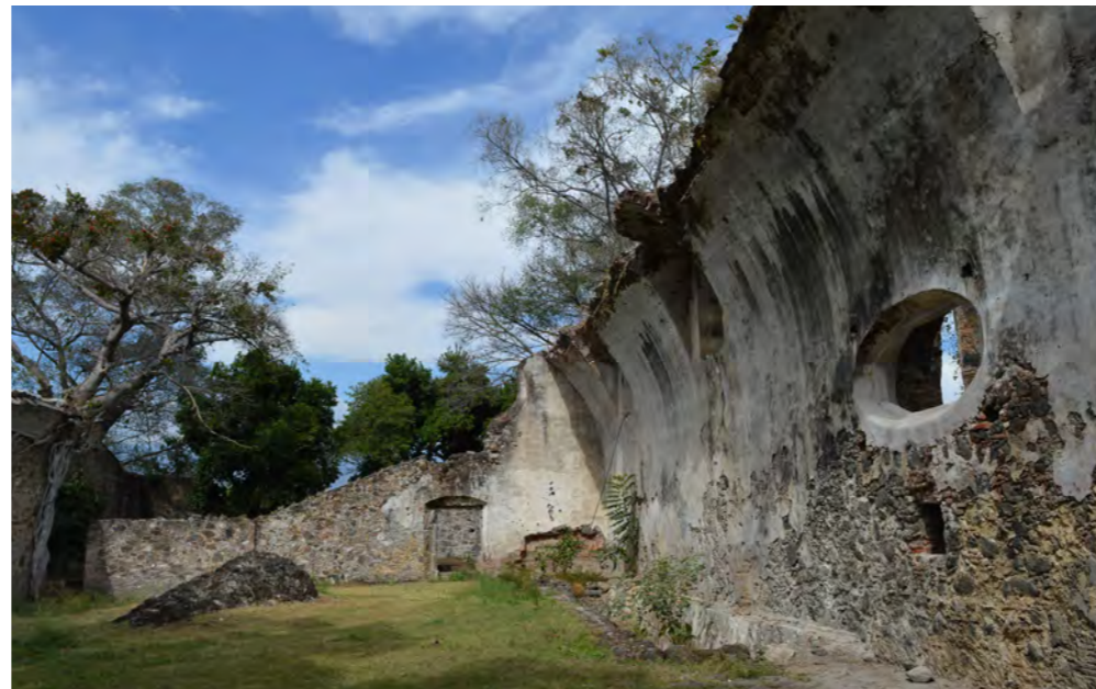
Gráfico 55. Ingenio de vapor con muros de piedra y ladrillo con aplanado, se conserva la fachada de acceso del siglo XIX y un único muro con curvatura de la cubierta en bóveda de cañon corrido.
