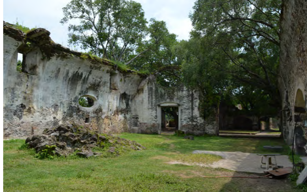
Gráfico 53. Ingenio de vapor con muros de piedra y ladrillo con aplanado, se conserva la fachada de acceso del siglo XIX y un único muro con curvatura de la cubierta en bóveda de cañon corrido.
