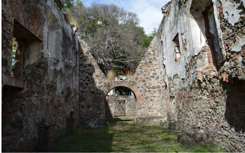
Gráfico 76. Interior de las ruinas de la casa principal, la parte inferior de los muros ha perdido todo su recubrimiento.
