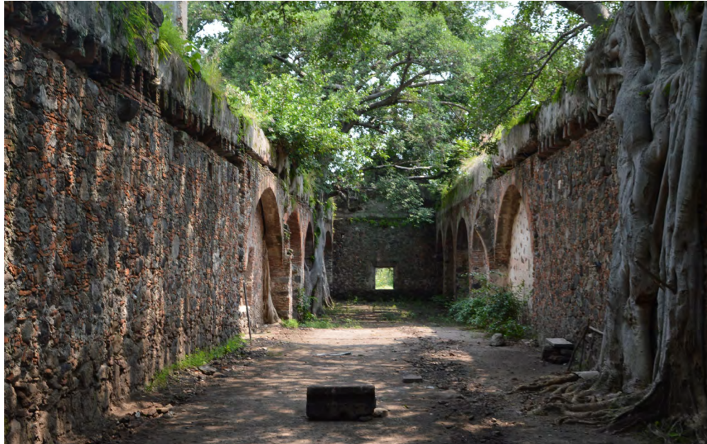
Gráfico 60. Interior de las ruinas en las que se instalaba el vivero, muros de piedra y ladrillo sin cubierta, sistema constructivo visible.
