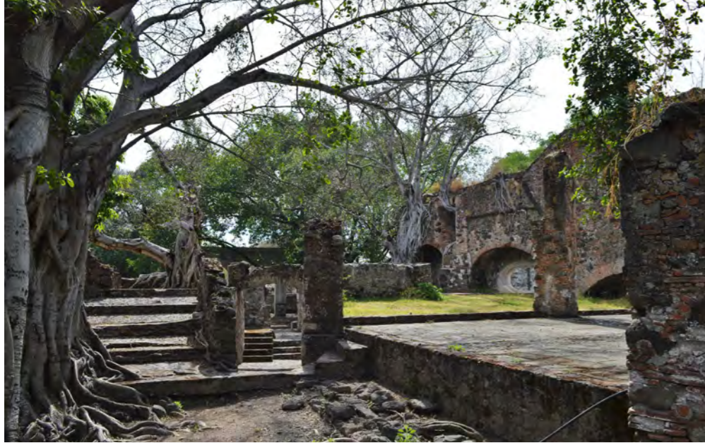
Gráfico 48: Zona de ruinas, muros invadidos por vegetación (amate), esta zona cuenta con medios niveles que crean terrazas.
