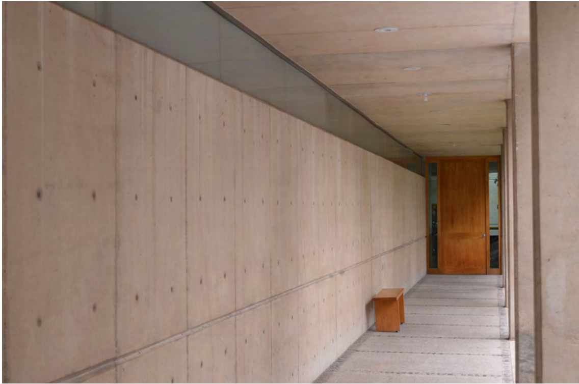
Gráfico 86: Pasillo de acceso principal.
