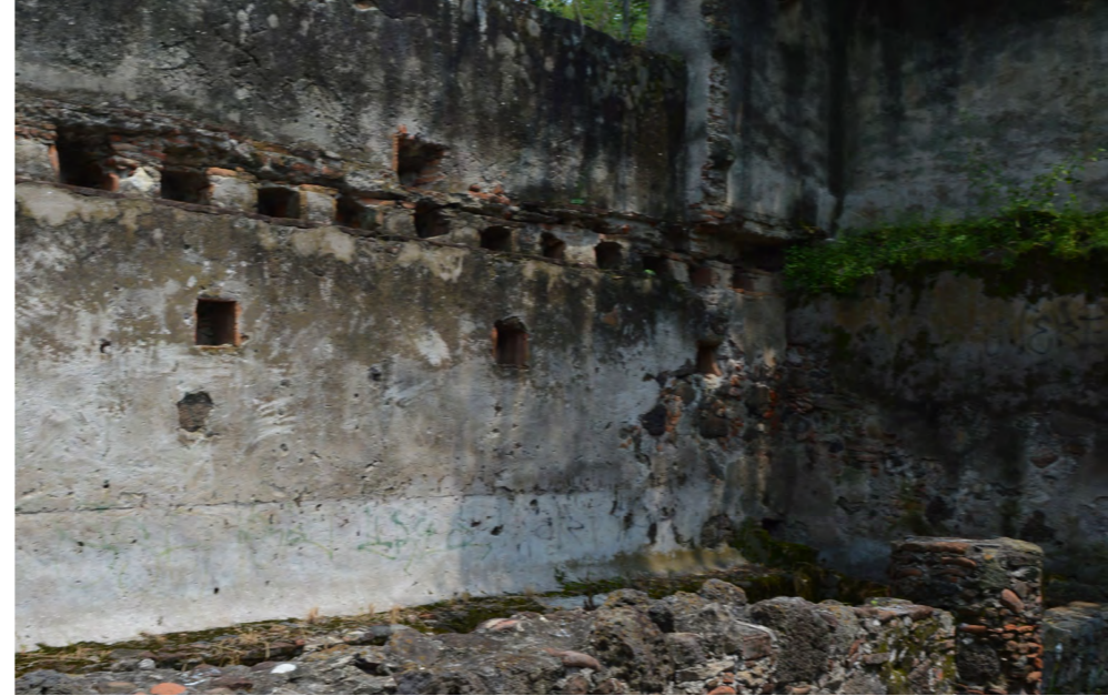
Gráfico 69. Interior de uno de los galerones, sistema constructivo de tapanco visible, los acabados del muro se conservan en su mayoría.
