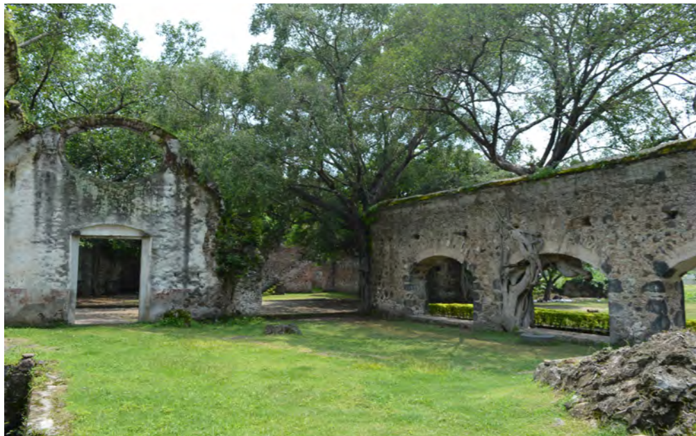
Gráfico 54. Ingenio de vapor, se mantiene muro con arcos rebajados de piedra e invadido por vegetación en la parte superior.
