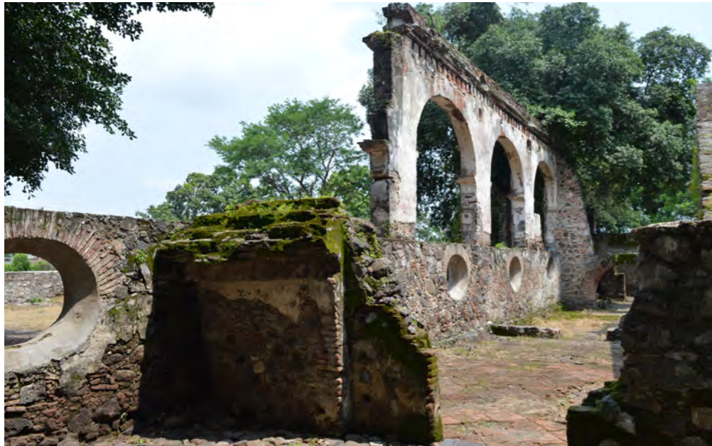
Gráfico 80. Pretil de 1.70 m. de altura con vanos ovalados y arco sobre esta, división de casa principal y huerta.
