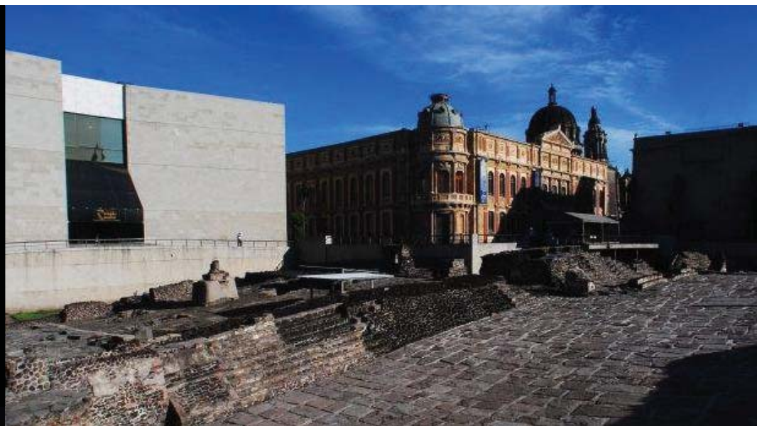
PATIO CENTRAL Y EDIFICIO DE SALAS DE EXPOSICION DEL MUSEO
