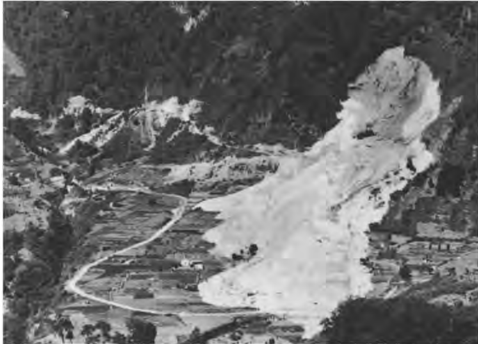
Figura 2. 2 Deslave en campo geotérmico Zunil, Guatemala; destruyendo infraestructura y obstruyendo vías de comunicación. Enero de 1990. Fuente: DiPippo (2008), (cortesía de Geothermal Resources Council).
