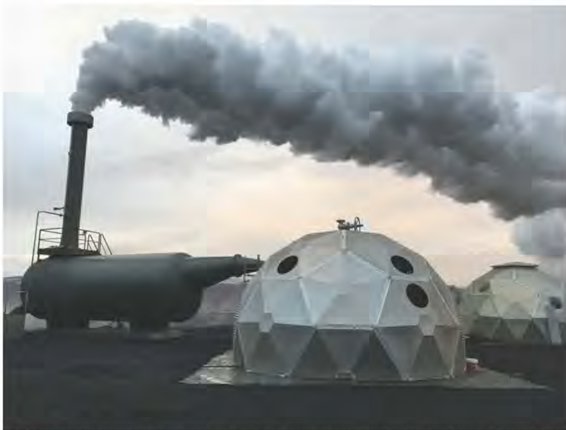
Figura 2. 7 Separador horizontal con silenciador para prueba de pozos ya perforados; Theistareykir, Islandia. Fuente: Archivo de la autora (2016).
