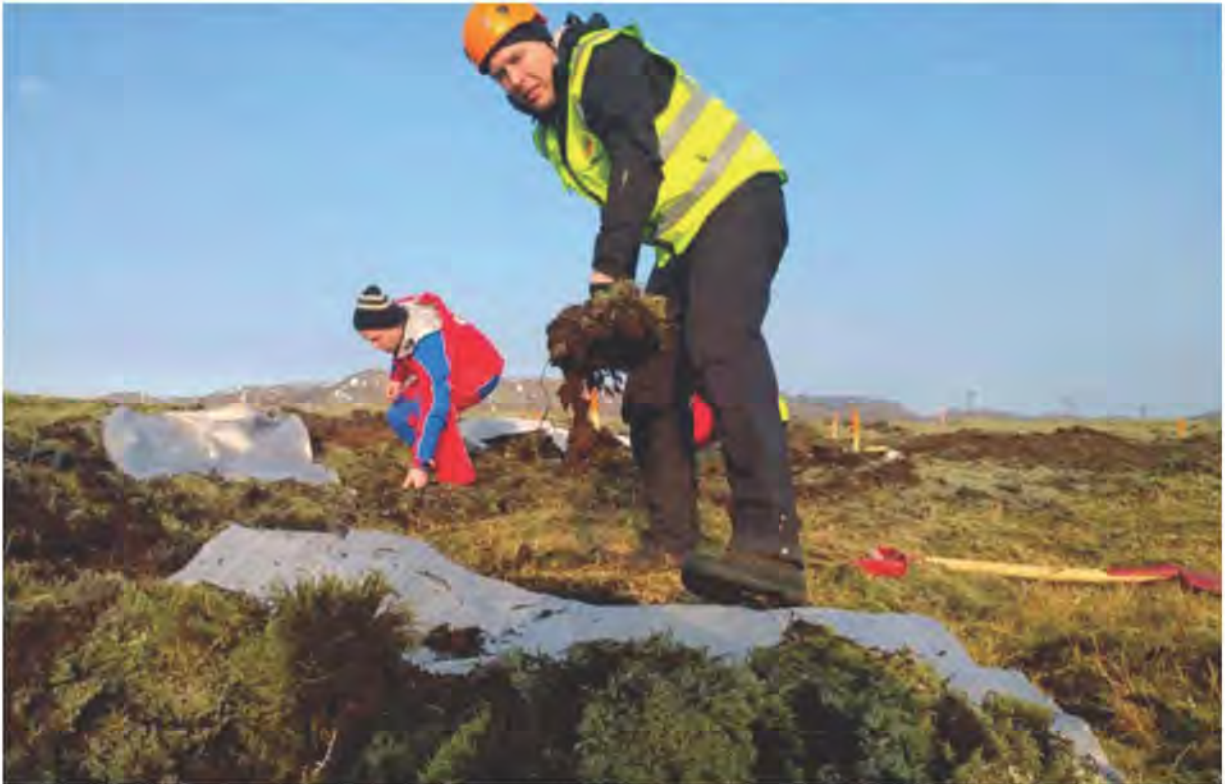
Figura 2.8 Recolección de musgo previo a la instalación de una nueva tubería proveniente de la planta de energía geotérmica Hellisheidi, Islandia; otoño del 2014. El musgo recolectado fue congelado a manera de preservarse para utilizarse en la etapa de restauración de la zona una vez ya instalada la tubería, actividad planificada para la primavera del año 2015. Fuente: Reykjavík Energy (2014).
