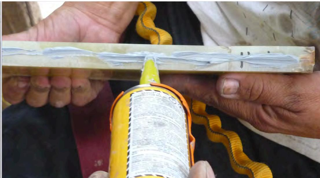
7. Fotografía Daniela Robles. Izquierda, fijación de los marcos. Derecha, vista desde el interior de la fachada poniente en la colocación de las placas de ónix.
