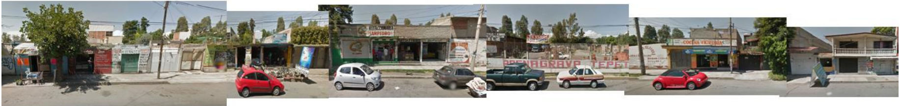
1. Larguillo de la Calzada Aquiles Serdán
