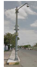
Cámara de vigilancia del Distrito Federal.
