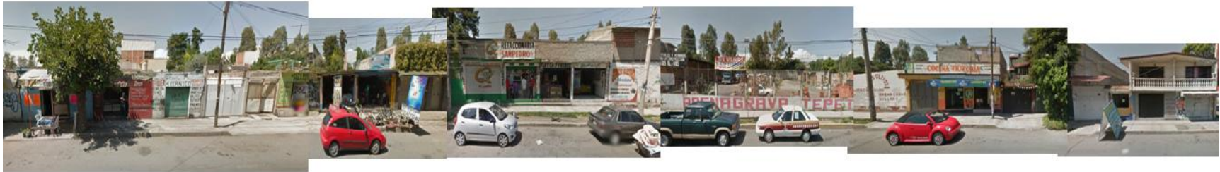
1. Larguillo de la Calzada Aquiles Serdán
