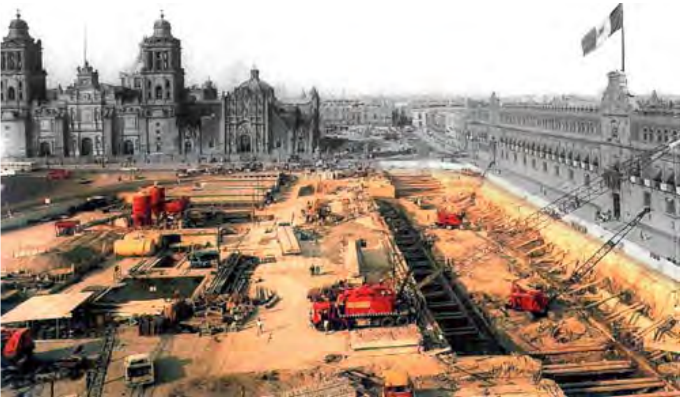
015. "Trabajos de construcción de la línea 2 del Metro" obtenida del libro Treinta años de hacer el Metro
