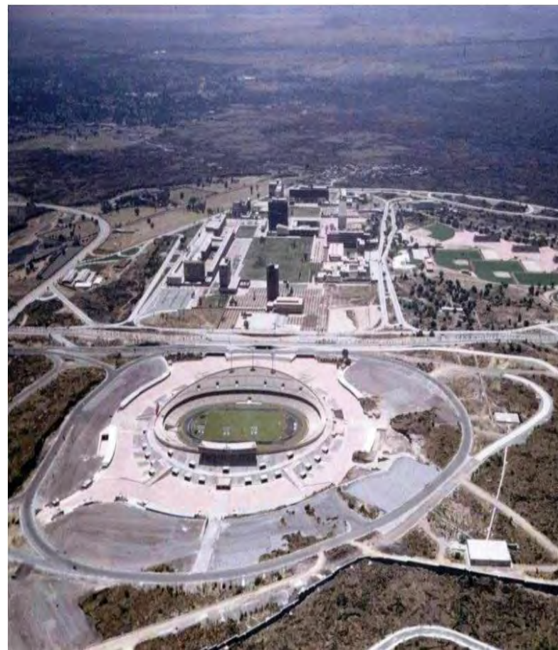
FIGURA 25. FOTOGRAFIA CIUDAD UNIVERSITARIA EN CONSTRUCCIÓN
