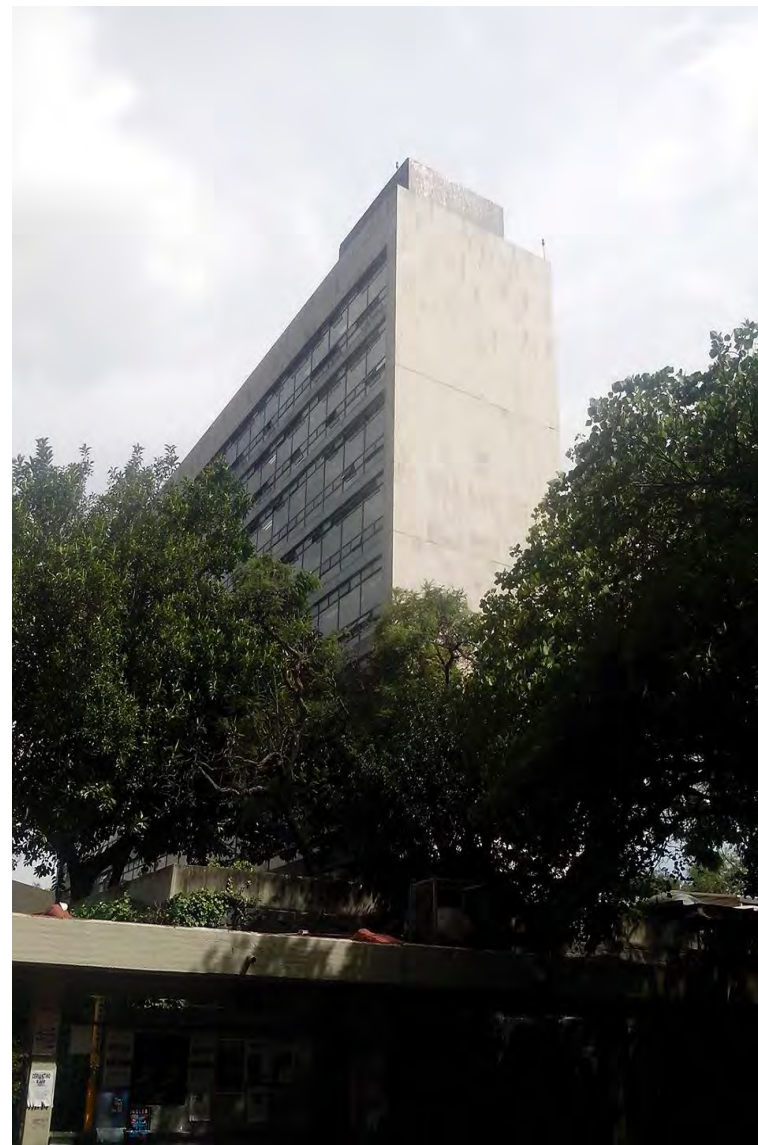
FIGURA 28. FOTOGRAFIA TOMADA DE LA FACHADA SUR DE LA TORRE DE HUMANIDADES I
