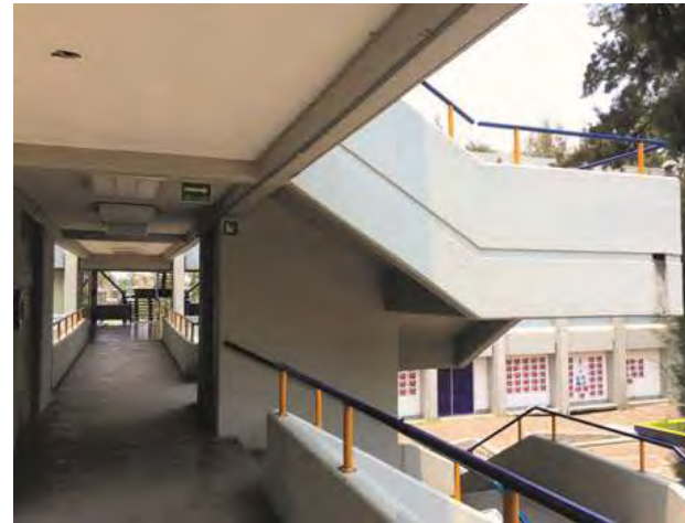
Fotografía 9. Núcleo de servicios entre edificios.
