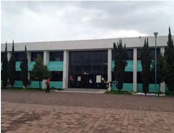
Fotografía 11. Fachada de edificio tipo de aulas.
