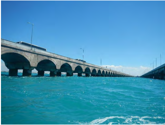
Figura 55. Foto muelle fiscal del puerto de Progreso. Arq. Estrada
