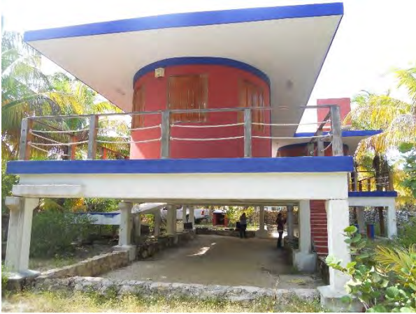
Figura 44. Palafito experimental. Fotografía de Arq. Estrada
