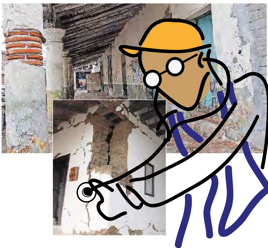
Figura 7. Collage de una auscultación de un inmueble dañado.
