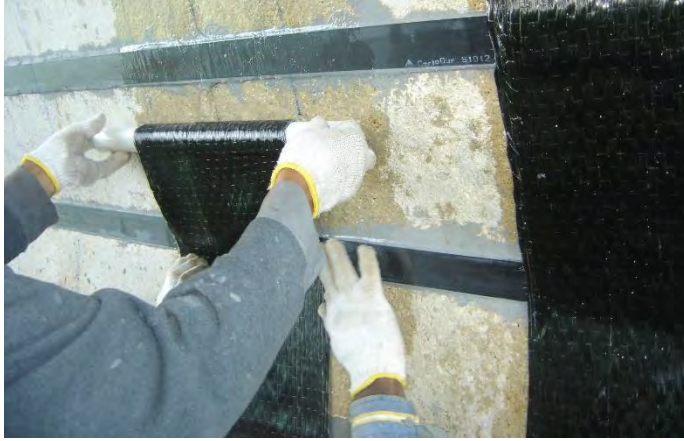
Figura 57. Foto reparación de arcos por medio de fibras de carbono. Cortesía CINVESTSAV- Mérida. 2008. Mtra. Alexia Zozaya.
