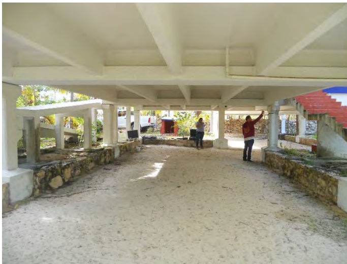
Figura 45. Estructura Palafito experimental. Fotografía de Arq. Estrada
