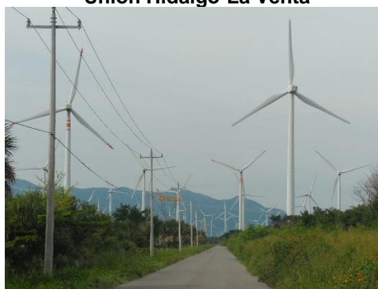
Figura 8. Carretera Estatal Unión Hidalgo-La Venta
