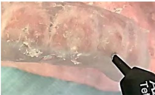
e) se realizan los canales de inyección con la fresa de  $\frac{1}{4}$
