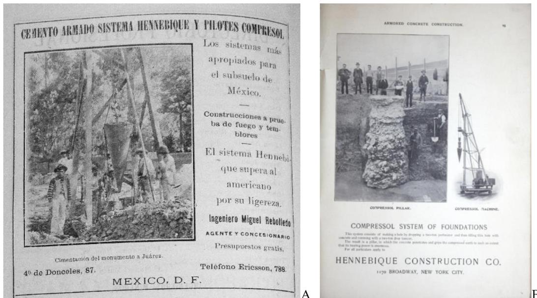
Fig. 5. A. Cemento Armado Sistema Hennebique y Pilotes Compresol. *Revista de Ingeniería*, No. 18, julio de 1913. B. Compressol System of Foundations. *Hennebique System* (U.S., 1908).
