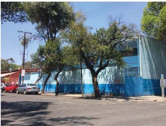
Fachada Sur Calle Malitzin
