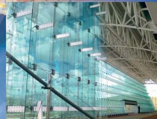
La araña consiste en una cruz de metal con un barreno al centro para ser conectada al sistema estructural. En cada extremo de la cruz o patas lleva soportes que reciben el tornillo de fijación al cristal y lo conectan a un soporte elástico. Este soporte es el que permite que cuando el cristal reciba cargas de vientos fuertes, se flexione y por lo tanto se reducen sus esfuerzos.
