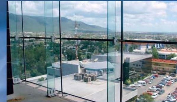
El Sistema de Sujeción Libre Kinetic a Costilla SSLK-C está sujeto como su nombre lo dice por medio de una costilla en lugar de una estructura o tensor.
