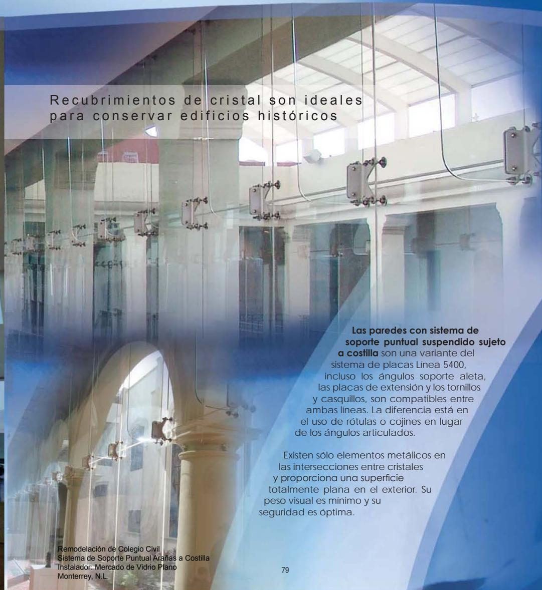
Las paredes con sistema de soporte puntual suspendido sujeto a costilla son una variante del sistema de placas Línea 5400, incluso los ángulos soporte aleta, las placas de extensión y los tornillos y casquillos, son compatibles entre ambas líneas. La diferencia está en el uso de rótulas o cojines en lugar de los ángulos articulados.
