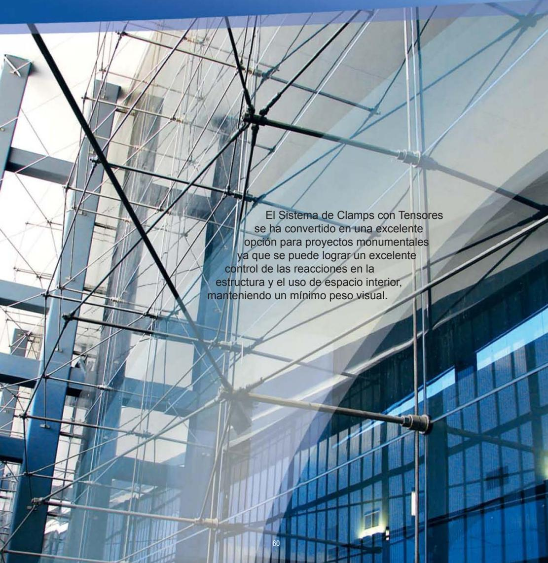
El Sistema de Clamps con Tensores se ha convertido en una excelente opción para proyectos monumentales ya que se puede lograr un excelente control de las reacciones en la estructura y el uso de espacio interior, manteniendo un mínimo peso visual.
