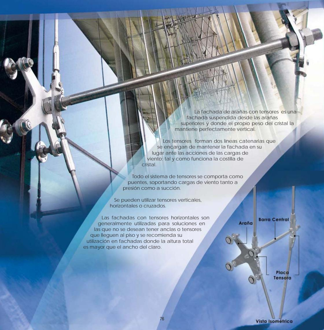
La fachada de arañas con tensores es una fachada suspendida desde las arañas superiores y donde el propio peso del cristal la mantiene perfectamente vertical.
