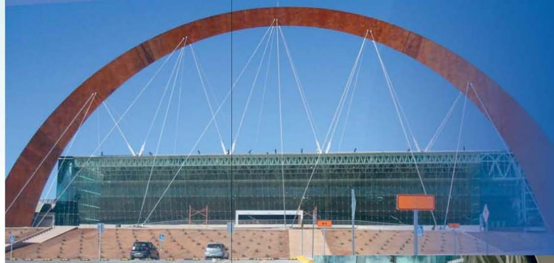
Este sistema parte del concepto de sujetar de manera individual cada cristal a la vez que permite su flexión bajo cargas de viento, reduciendo así las cargas que se han de resistir.
